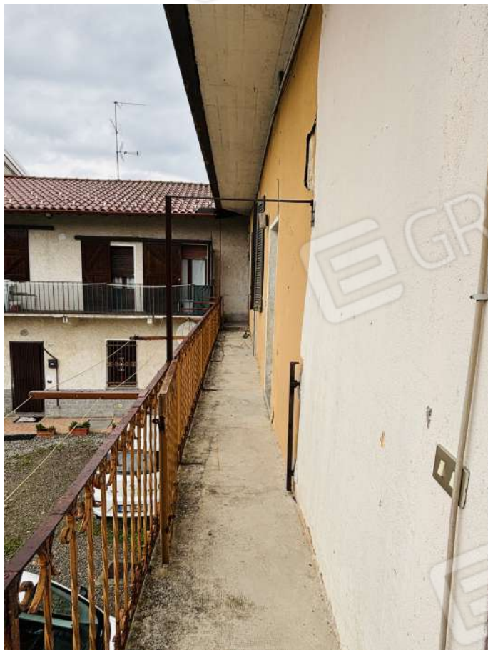
Fotografia 41. Lotto B. Ballatoio comune.
