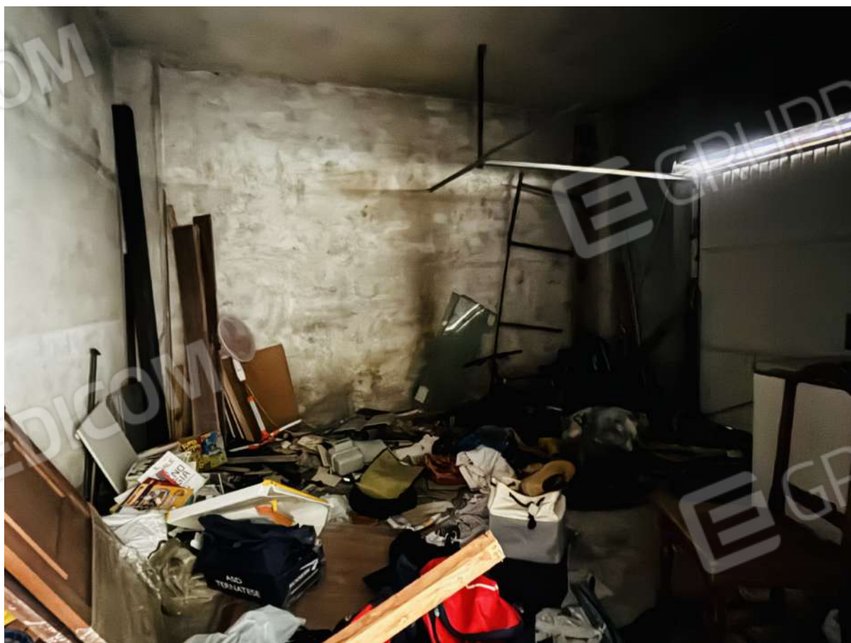
Fotografia 46. Lotto C. Autorimessa. Vista interna.
