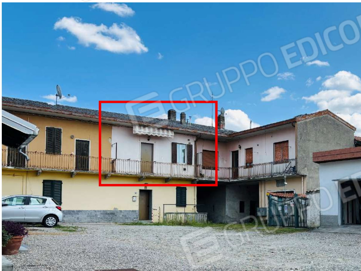
Fotografia 03. Lotto A. Appartamento a piano primo. Fronte.
