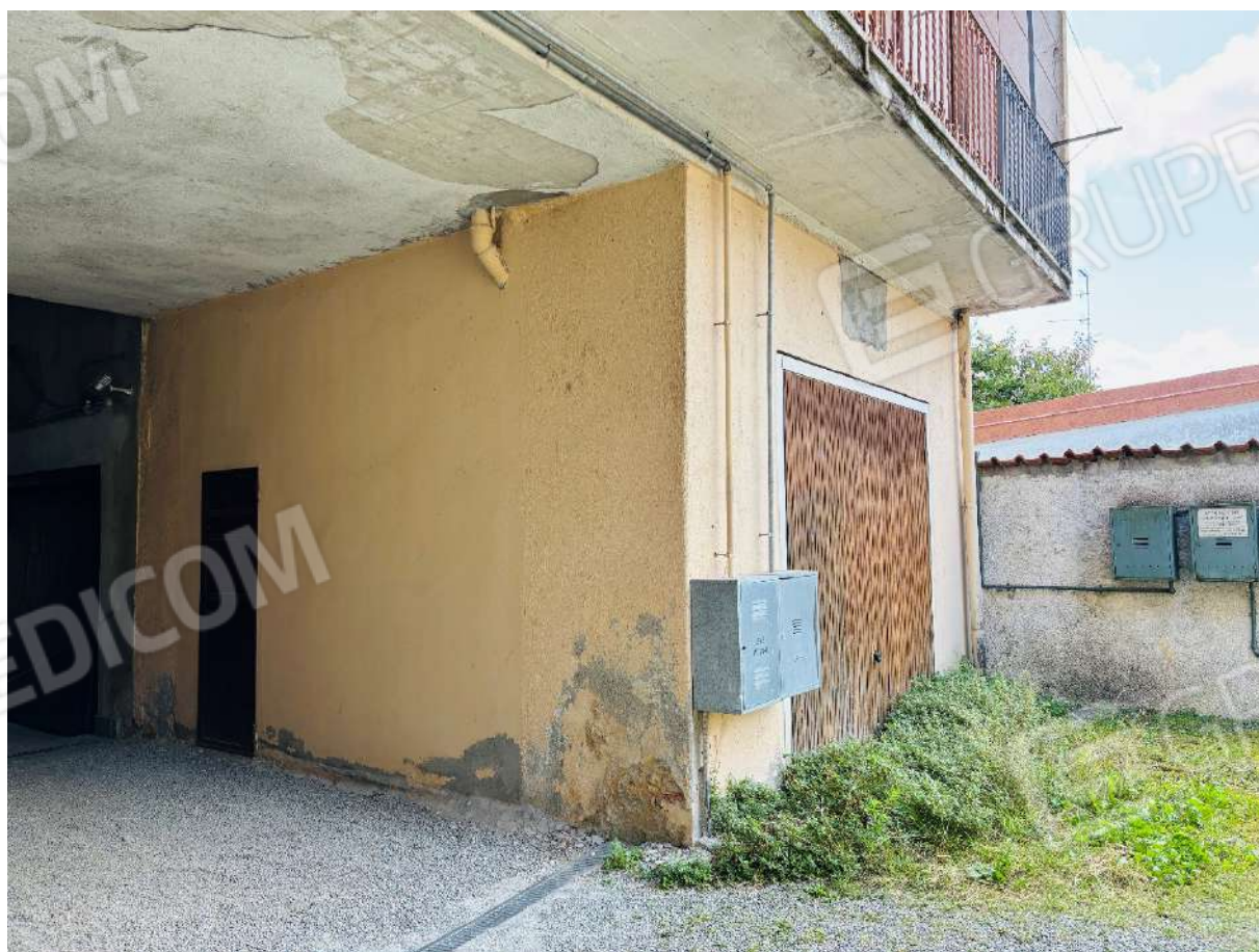
Fotografia 44. Lotto C. Autorimessa.
