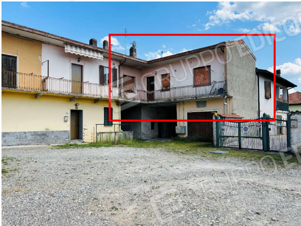
Fotografia 19. Lotto B. Appartamento a piano primo. Fronte.
