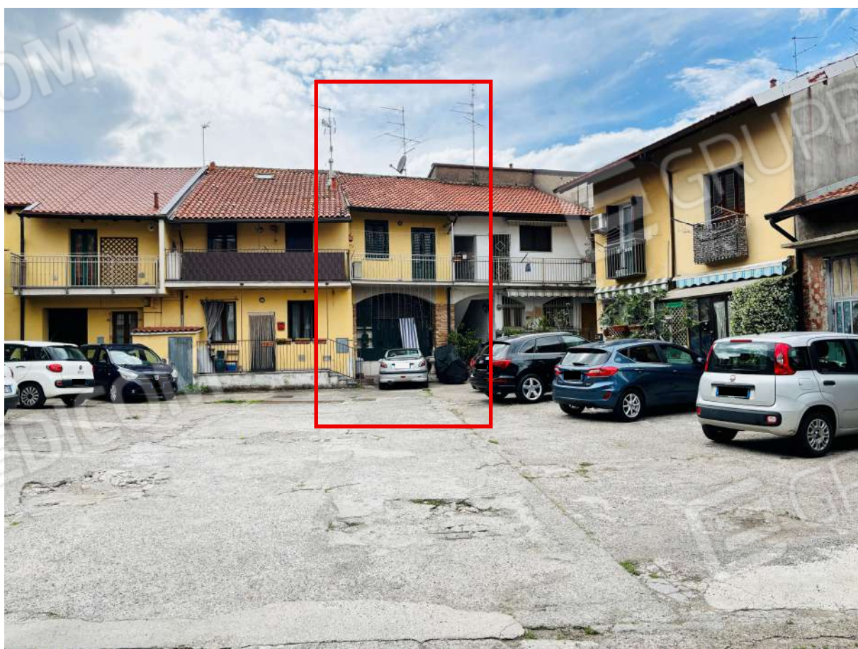
Fotografia 02. Vista da corte interna.
