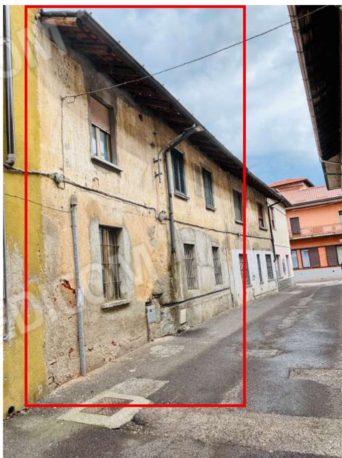
Fotografia 32. Prospetto su via G. Zaffaroni.
