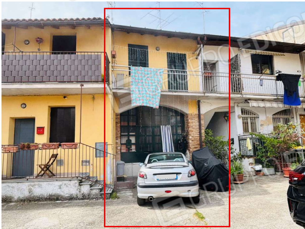
Fotografia 03. Fronte con ingresso.
