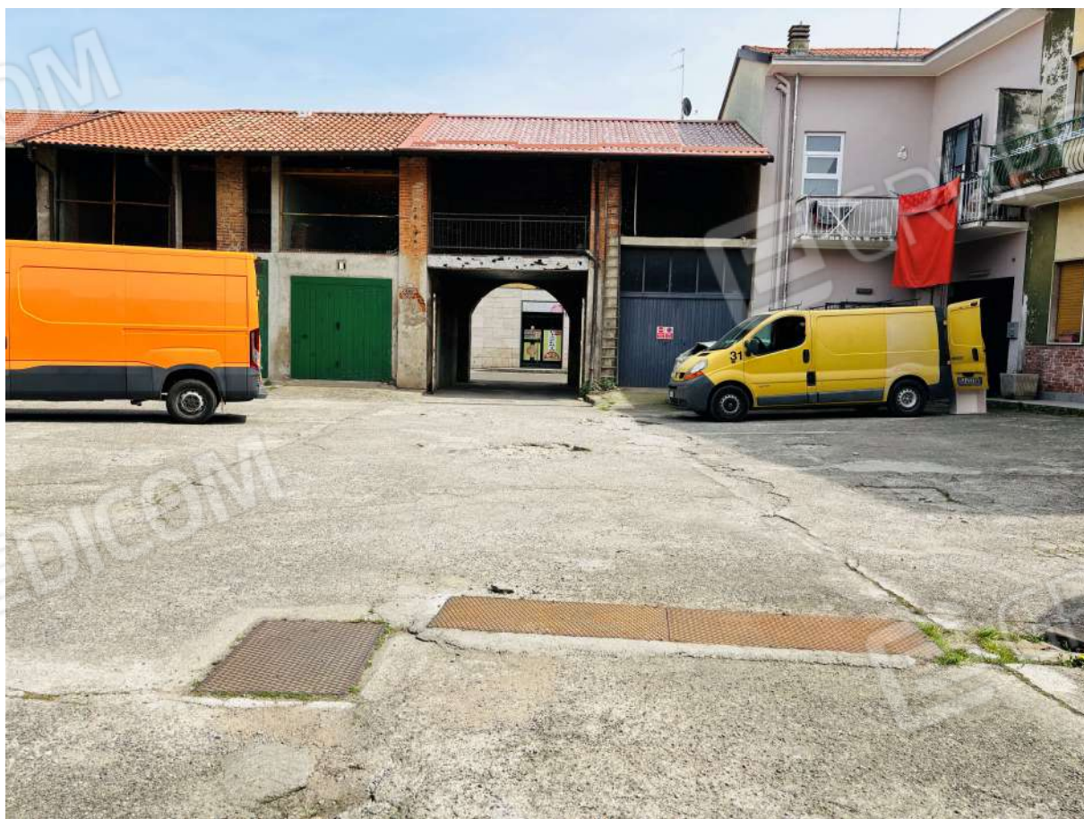
Fotografia 04. Cortile interno con adrone.
