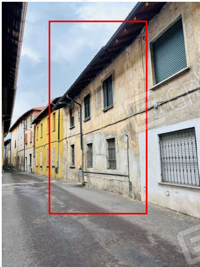
Fotografia 31. Prospetto su via G. Zaffaroni.
