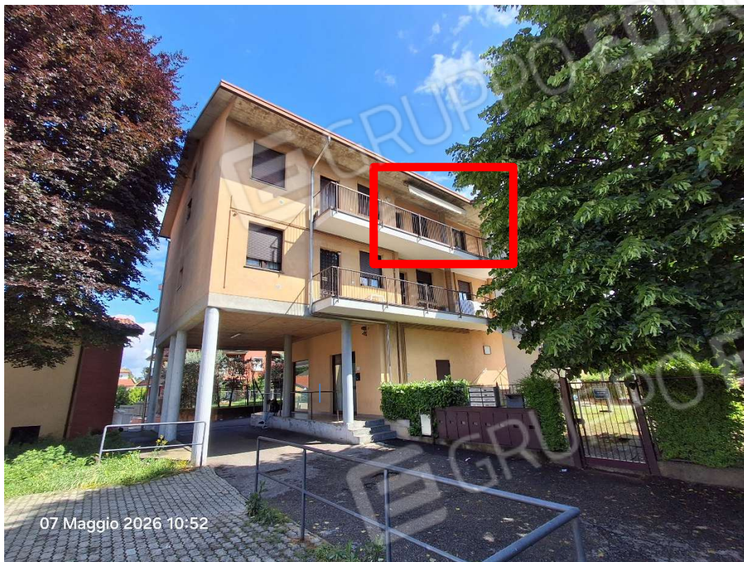
FOTO 3 - Vista ingresso condominio ed unità immobiliare da parcheggio esterno
