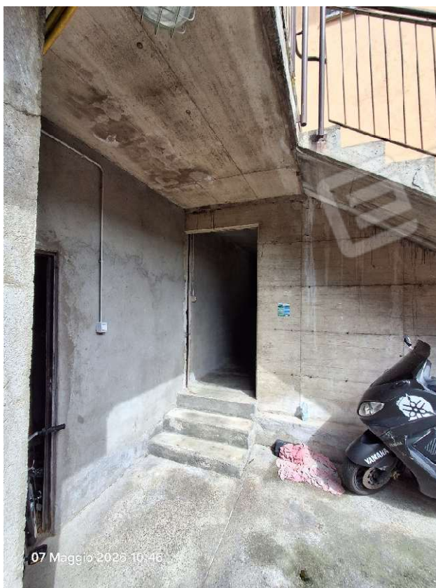
FOTO 10 - Vista esterna accesso piano interrato
