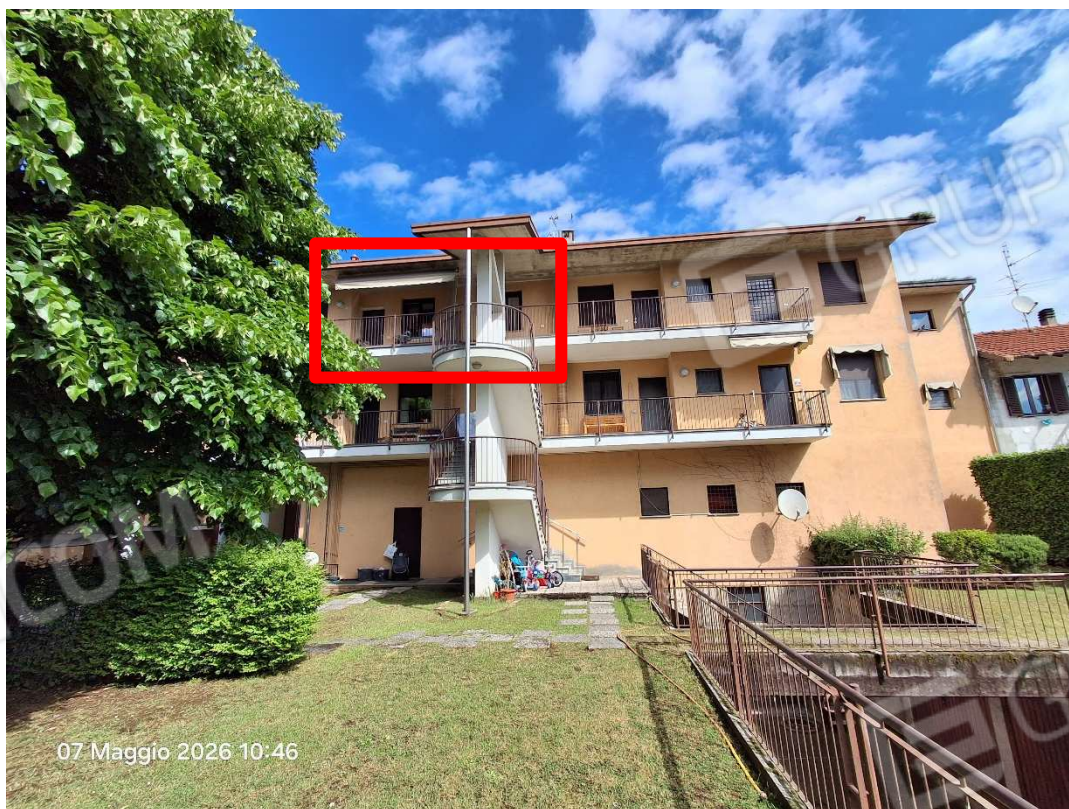
FOTO 2 - Vista esterna dal cortile comune
