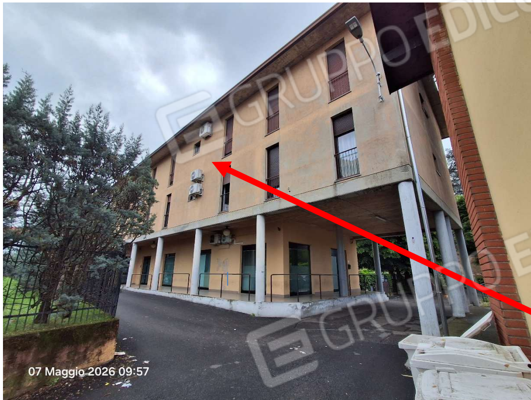
FOTO 1 - Vista esterna immobile da Vicolo Aperto
