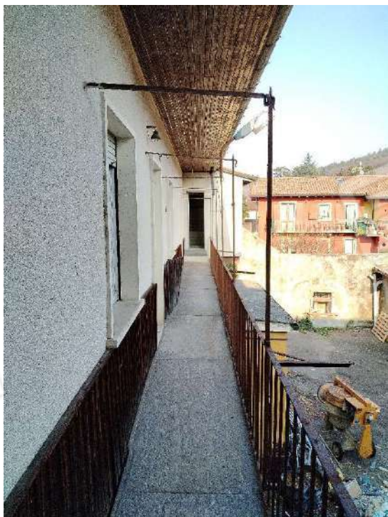
22) Ballatoio di distribuzione a piano primo ;
