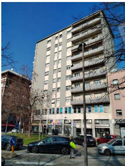
1) Vista del fabbricato da P.zza Risorgimento,
