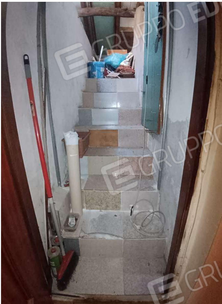
Vano Scala sottotetto
