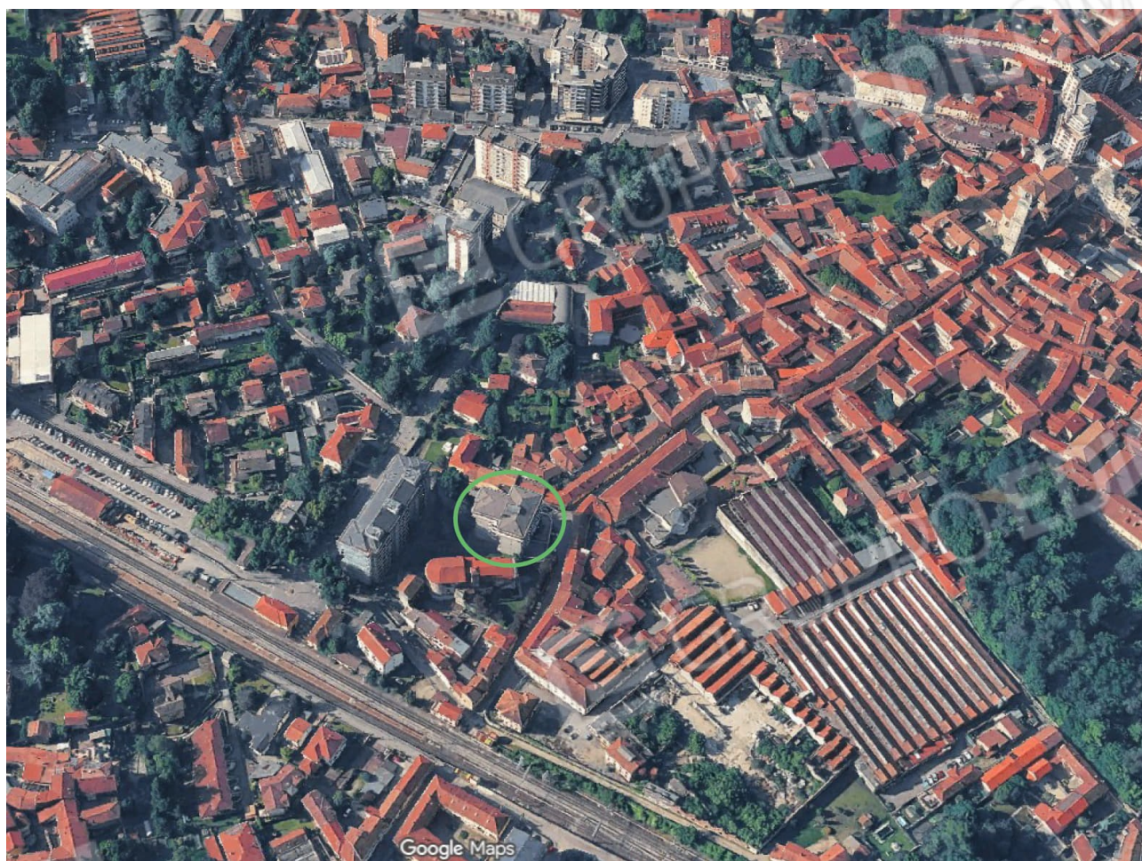
Foto 14 - VISTA AEREA CON LOCALIZZAZIONE CONDOMINIO
