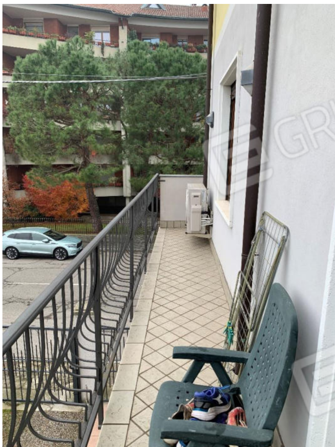
05 balcone lato cortile interno a piano primo
