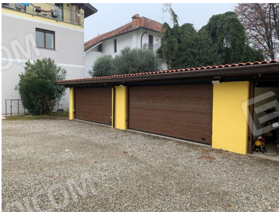
02 edificio a destinazione box
