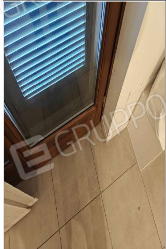
Particolare dei serramenti esterni
