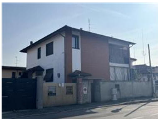
Fronte su strada e fronte nord
