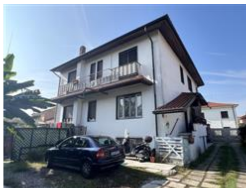
Fronte est su cortile comune
