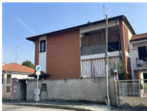
Fronte in affaccio su Via San Sebastiano
