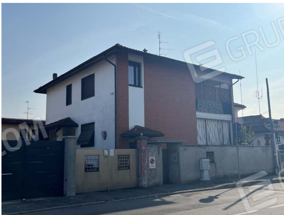
Fronte su strada e fronte nord
