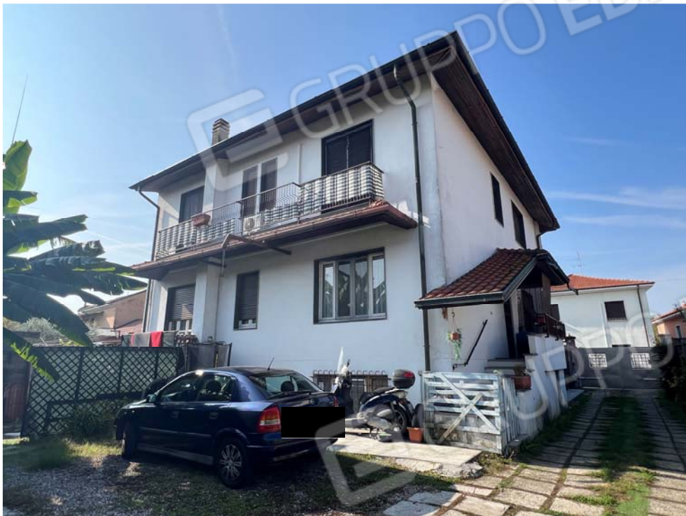
Fronte est su cortile comune
