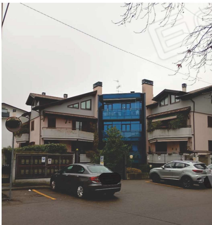
1) Veduta frontale del fabbricato,
