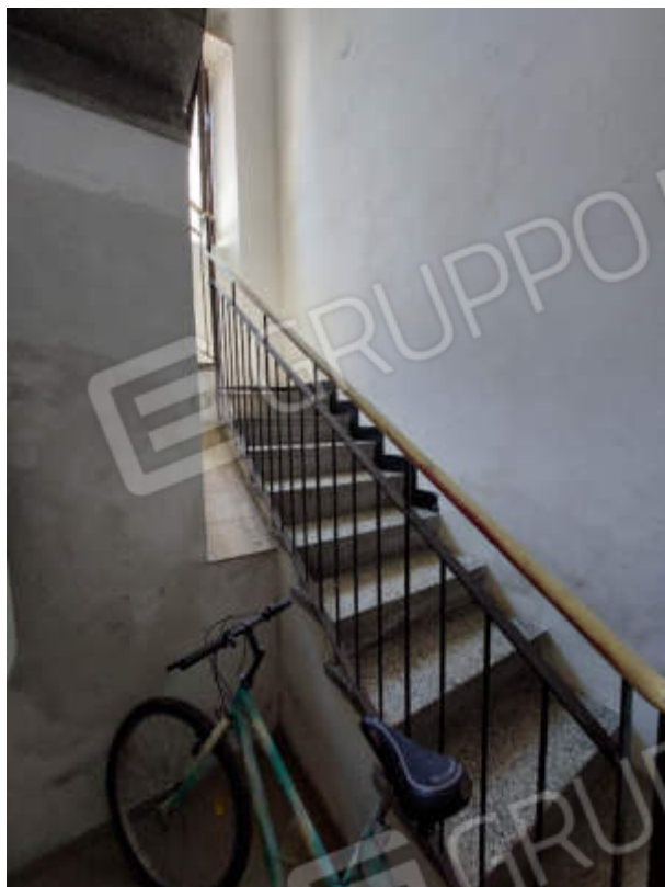
FOTO 7 Vista esterna PT – Vano scala comune
