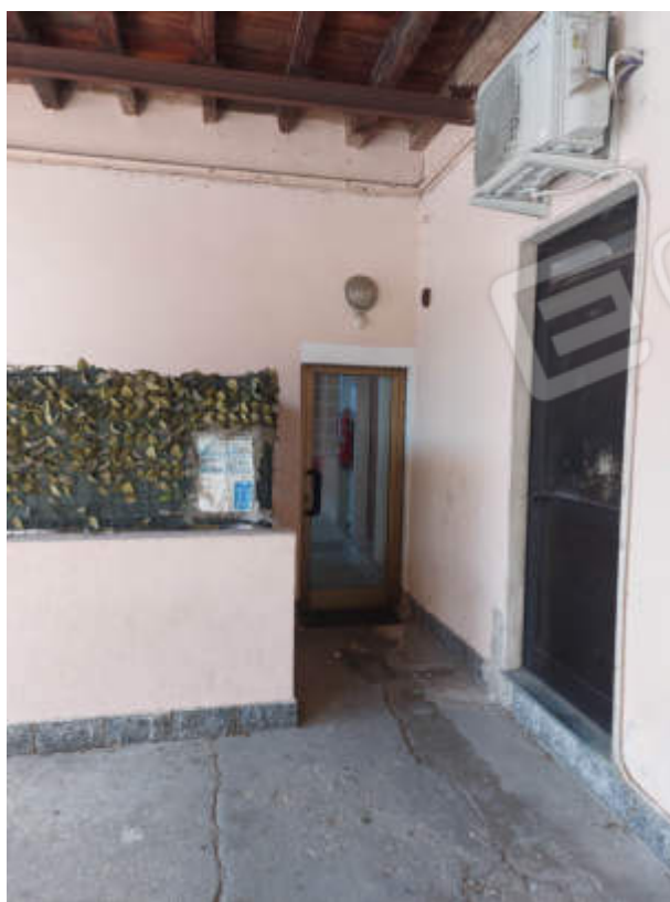
FOTO 6 Vista esterna PT – Ingresso al vano scala comune
