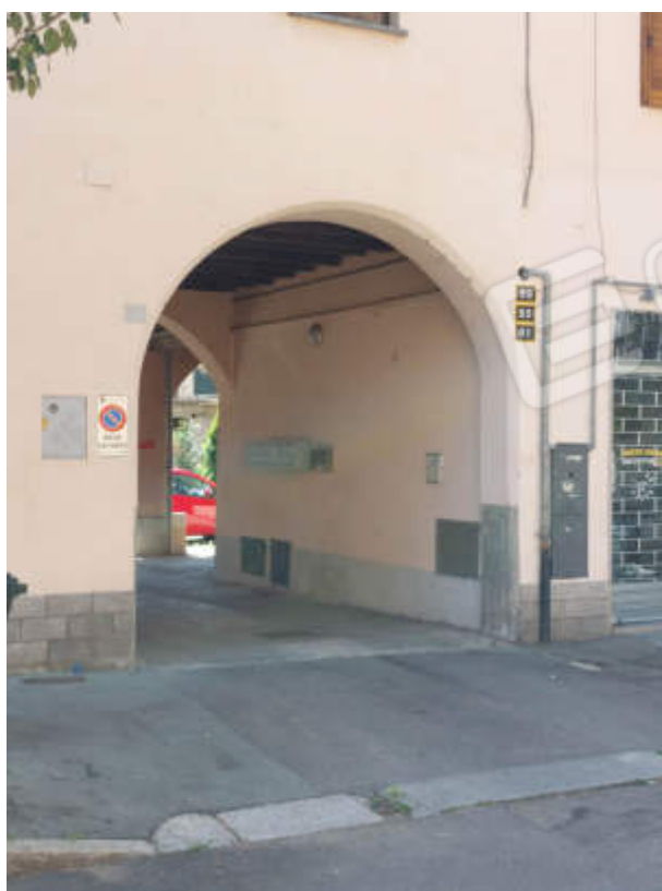
FOTO 4 Vista esterna – Ingresso alla corte comune
