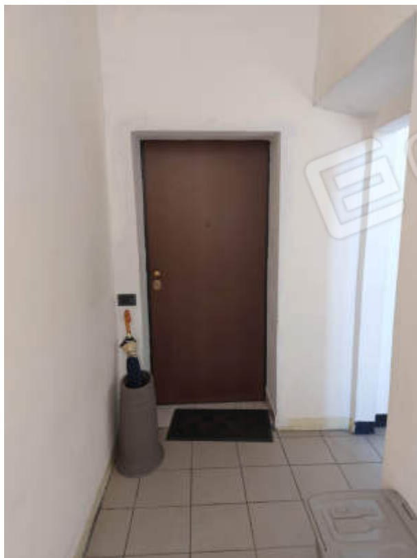
FOTO 8 Vista esterna P2 – Ingresso
