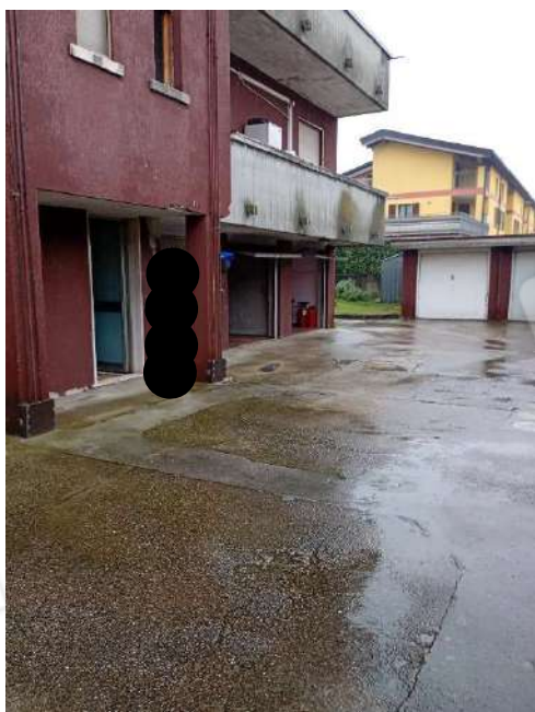
23) Zoccolo con i box a piano Semi-interrato,
