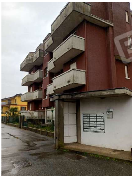
1) Veduta del fabbricato dall'ingresso carraio /pedonale,
