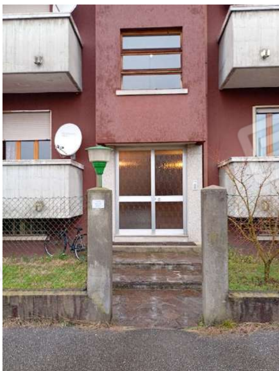
3) Ingresso all'androne delle scale/ascensore,
