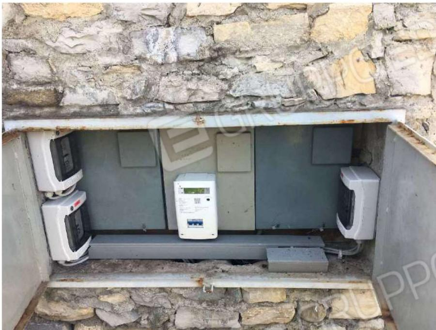
30. DETTAGLIO OPERE SVOLTE: vano contatore ENEL esterno
