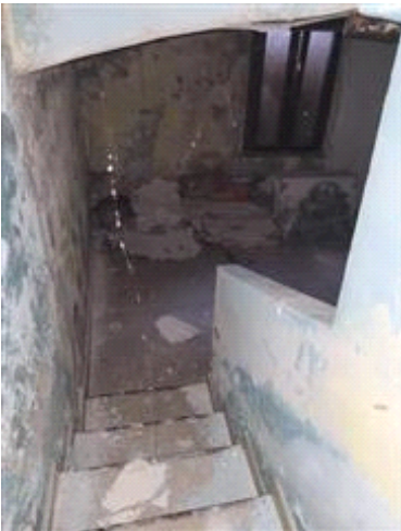
La scala interna, verso il locale cantina
