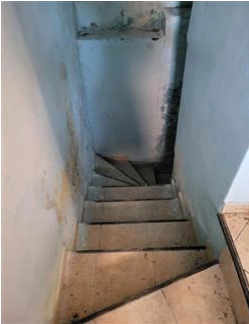
Vista del vano scala interno
