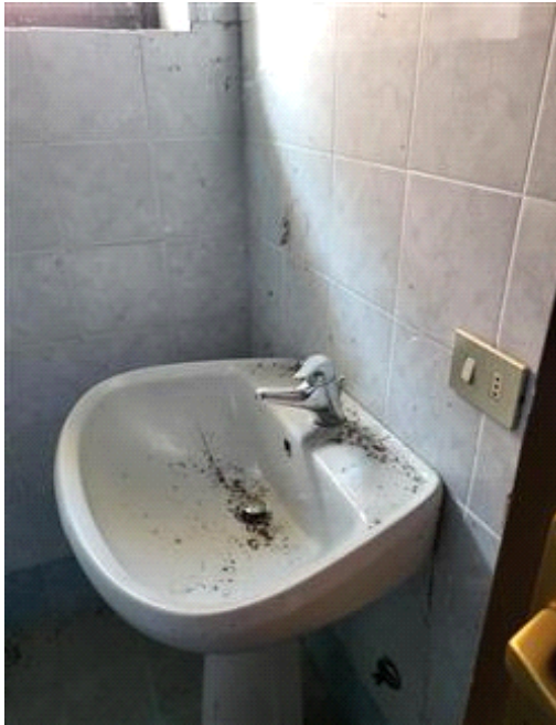
Vista interna del bagno
