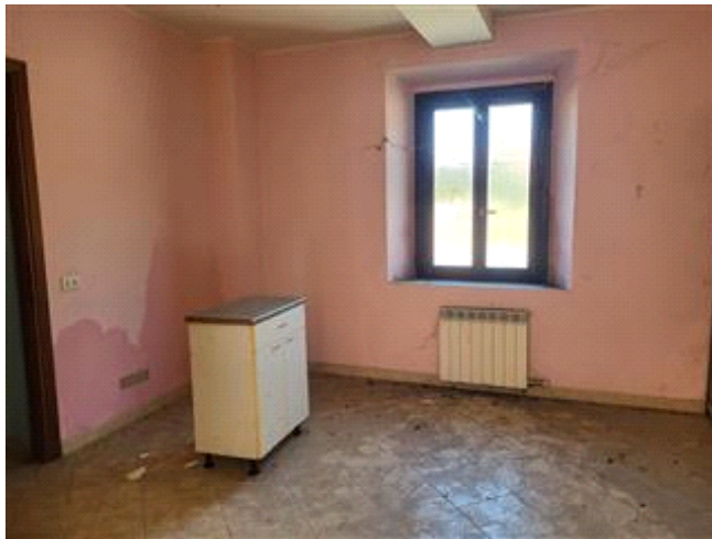
Vista interna-lato con finestra.
