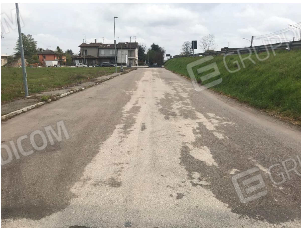
Foto n. 2 – Area urbana (Via Martinengo Lotarengo) p.lla 1472
