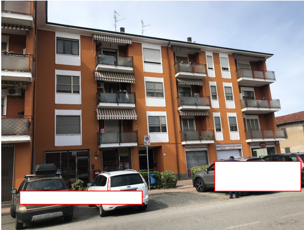
Foto n. 2: Prospetto principale su Via Umberto I
