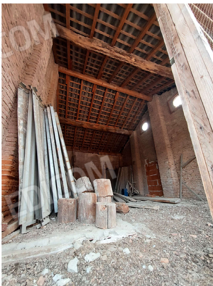
CORPO 5b – Deposito Vista interna piano primo
