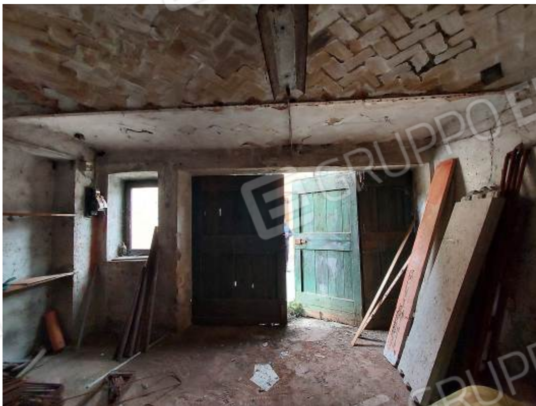
CORPO 5b – Deposito Vista interna piano terra
