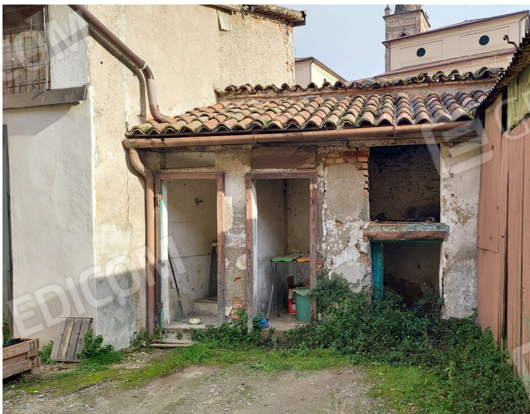
CORPO 5a - Ripostigli/latrine 5a.3
