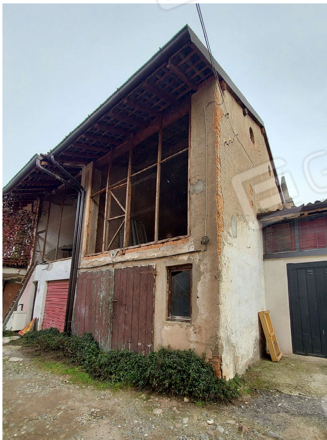
CORPO 5b – Deposito
