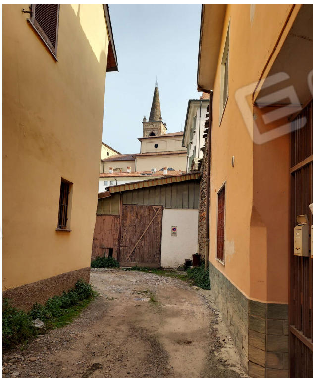
Accesso alla corte da Via San Dionigi
