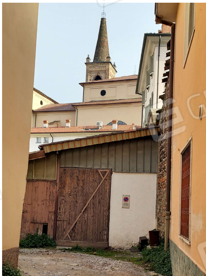
CORPO 5a - Magazzino 5a.1
