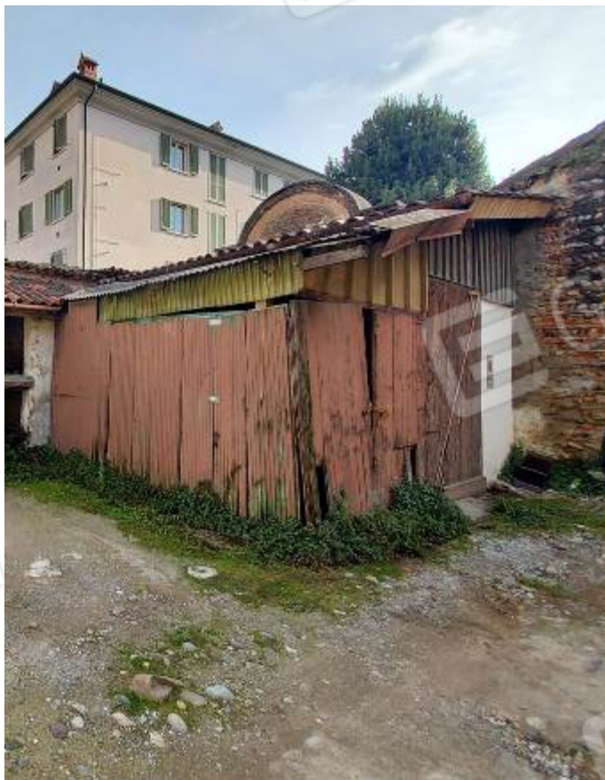
CORPO 5a - Magazzino 5a.2
