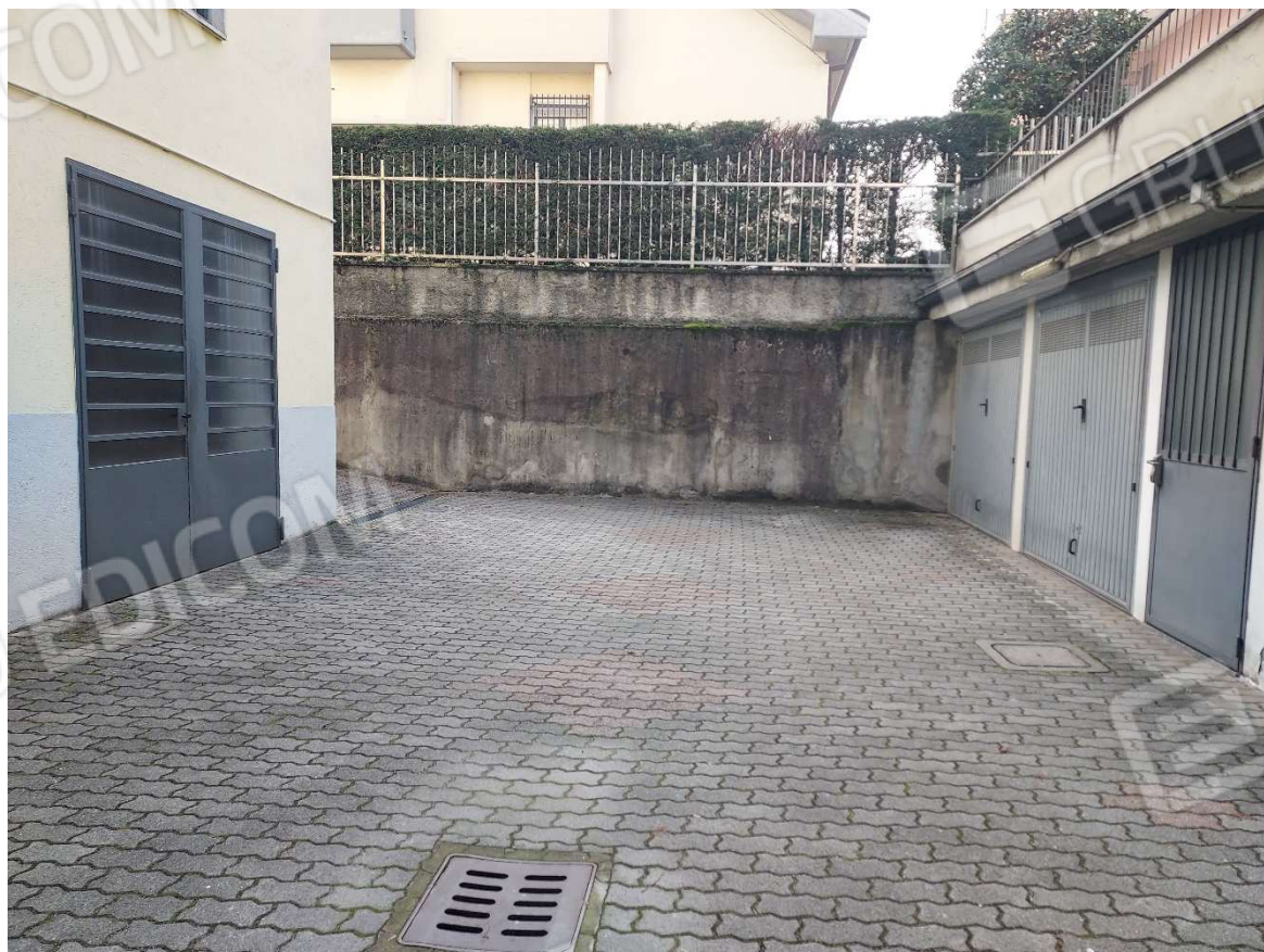
Vista del cortile
