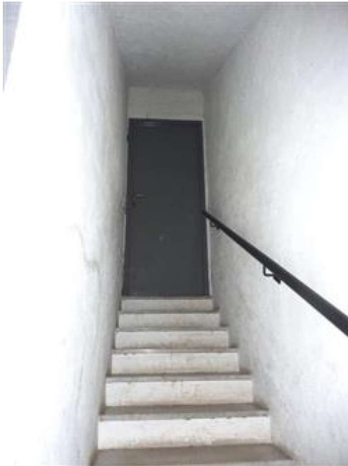
Scala di accesso alle cantine
