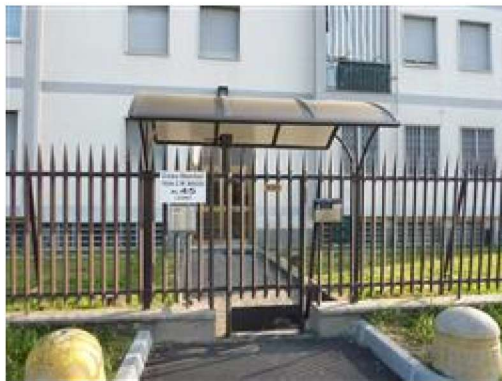
L'ingresso al fabbricato
