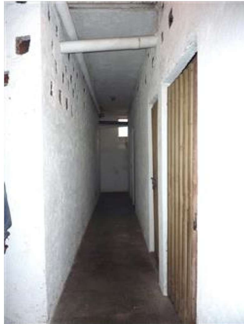
Corridoio di accesso alle cantine
