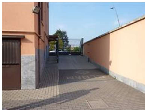
La rampa carraia di accesso
