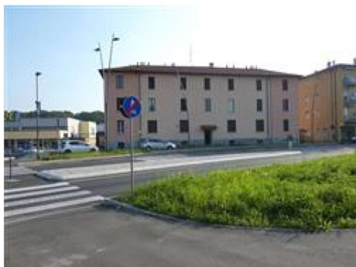
Il fabbricato fronte viabilità principale
