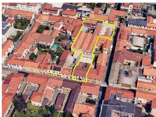
Vista aerea dell'intero compendio
