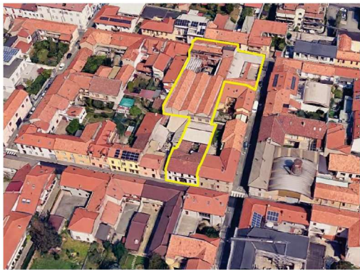
Vista aerea dell'intero compendio
