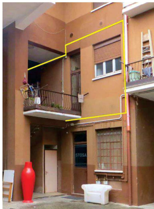
Affaccio a Sud in corte
