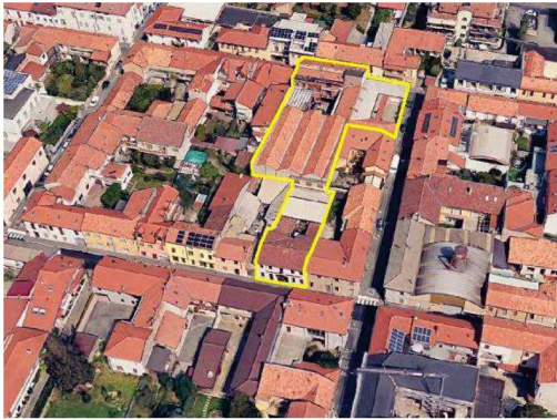
Vista aerea dell'intero compendio
