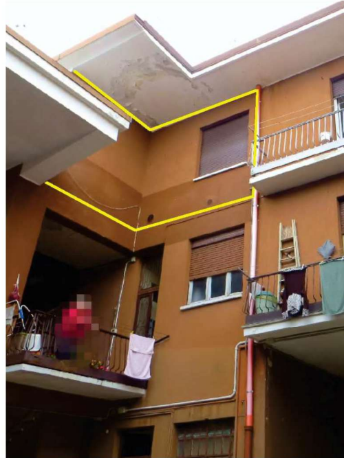
Affaccio a Sud in corte
