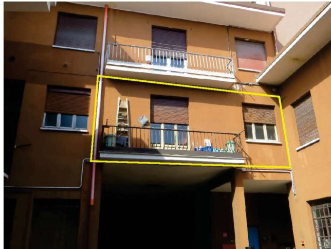
Affaccio a Sud in corte
