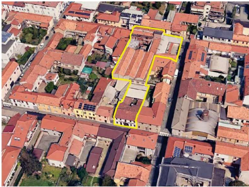
Vista aerea dell'intero compendio
