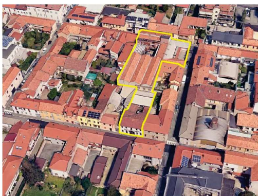
Vista aerea dell'intero compendio
