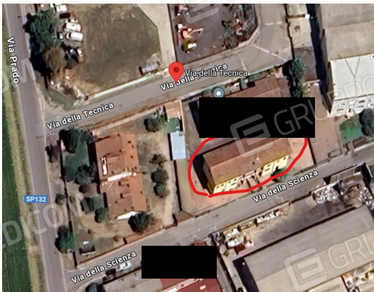
Inquadramento Generale Corpo di Fabbrica – vista aerea
