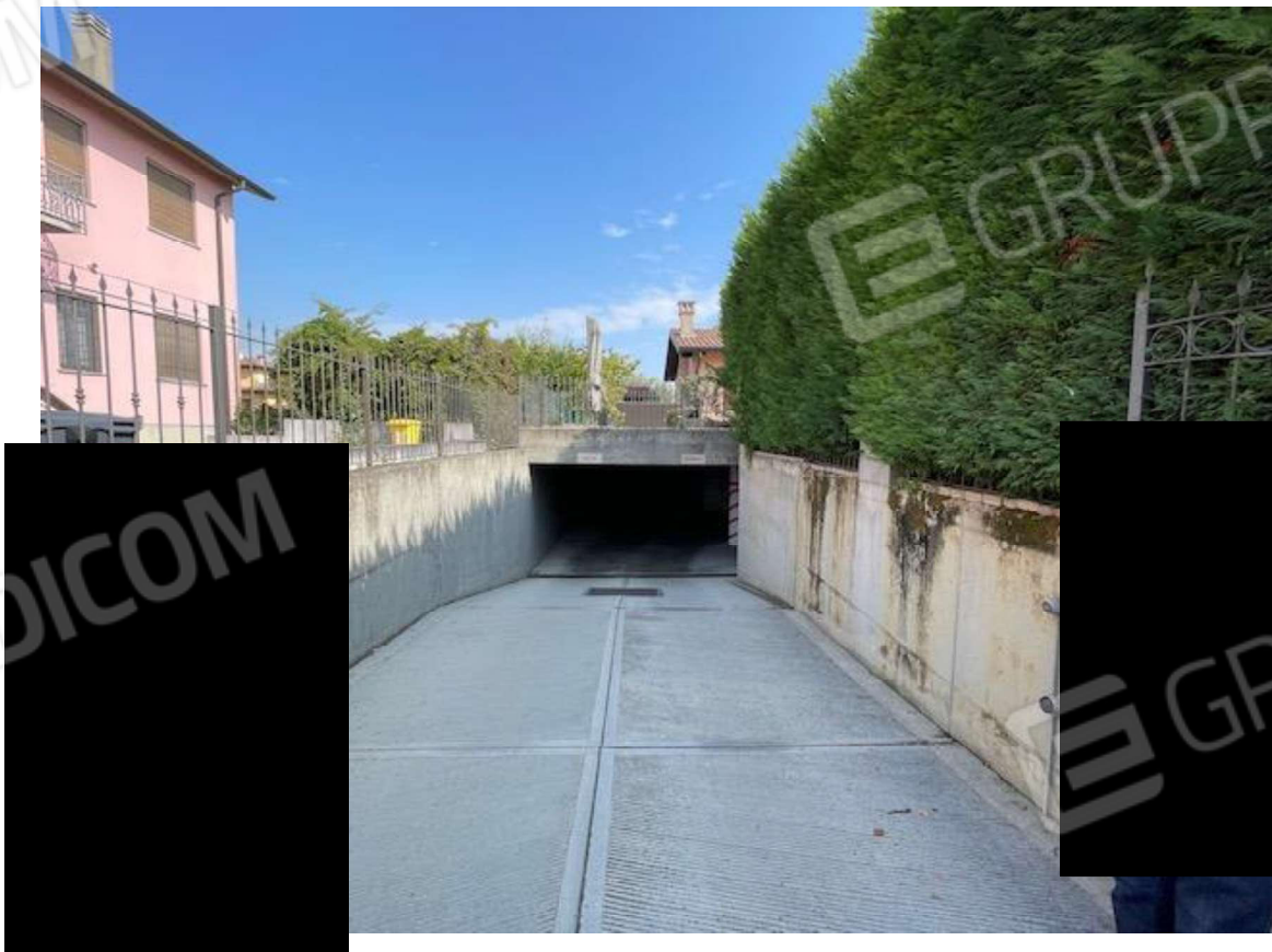
Rampa di Accesso al Piano Semi-interrato
