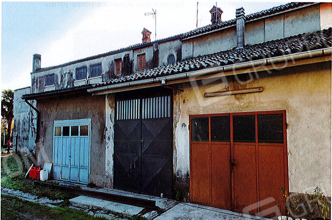
Autorimessa – prospetto verso il cortile comune
