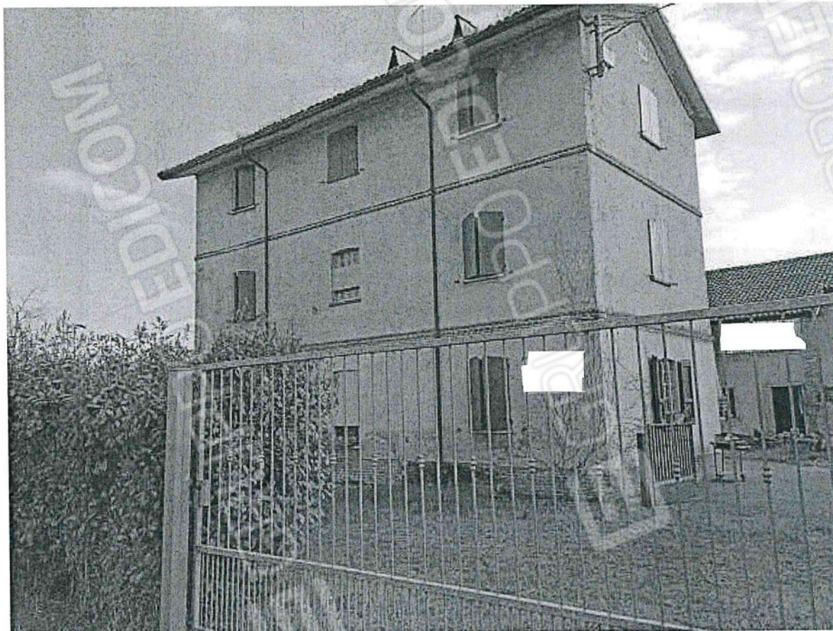
Prospetto principale lato Nord
