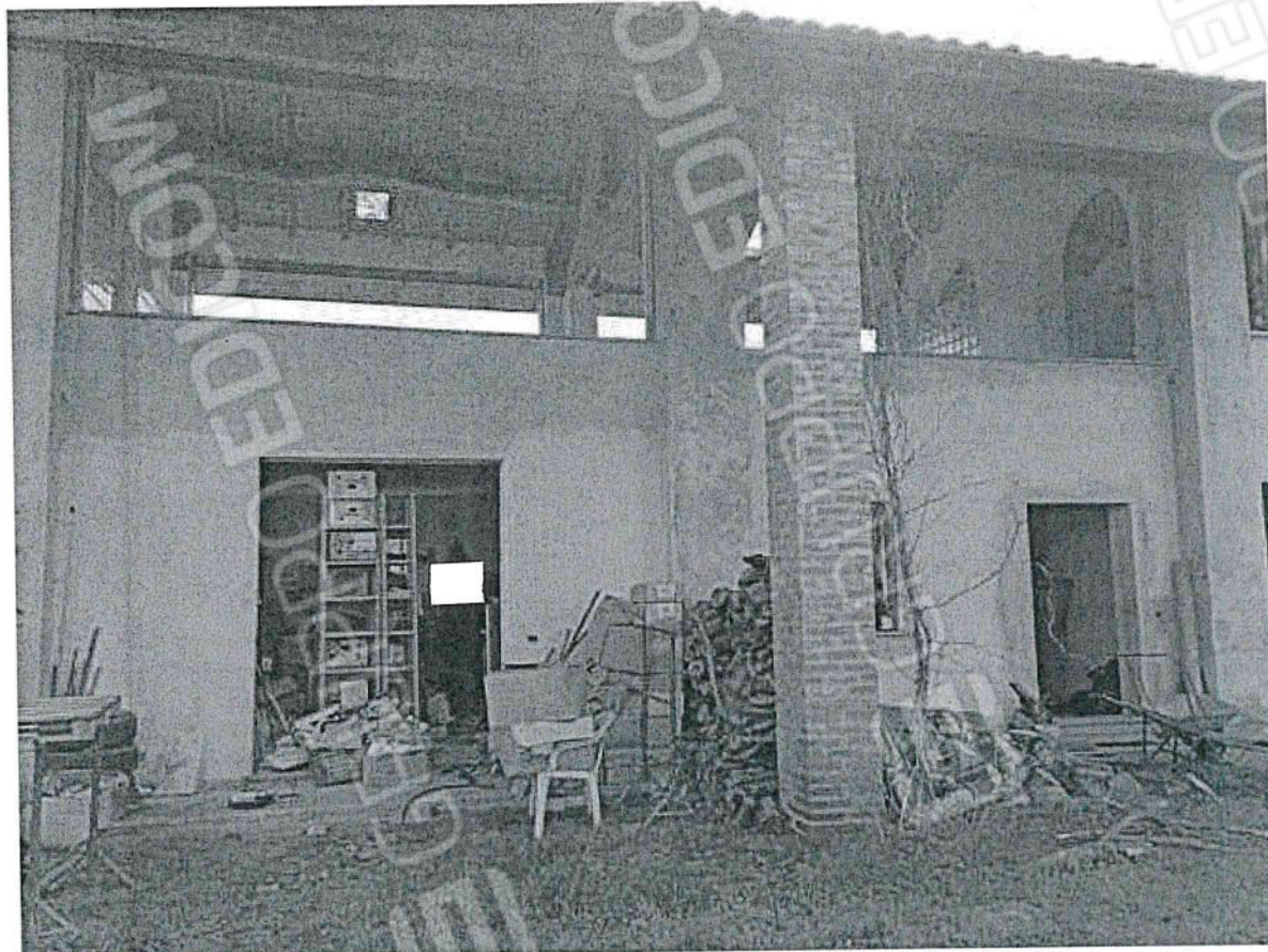
Fabbricato locali accessori e cassero 1P
