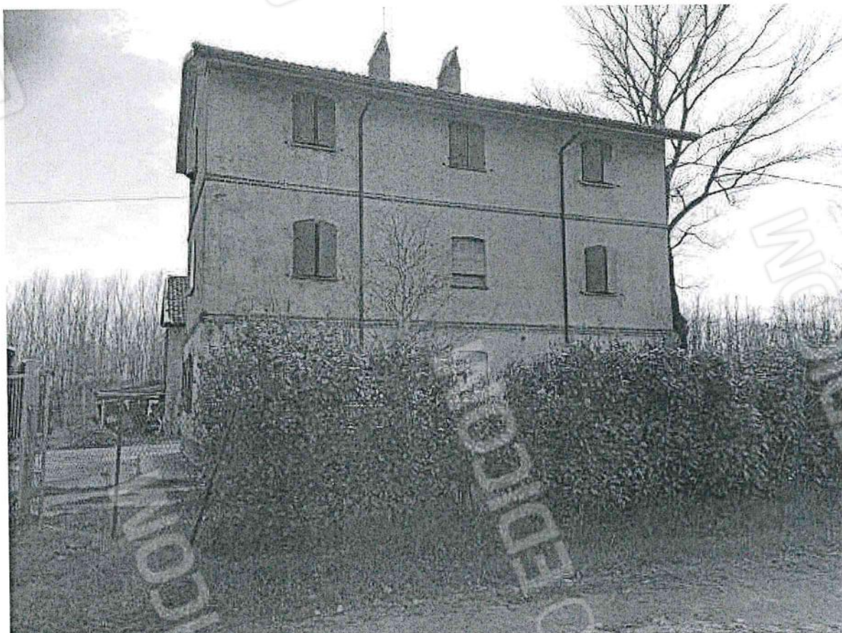
Prospetto principale lato Nord
