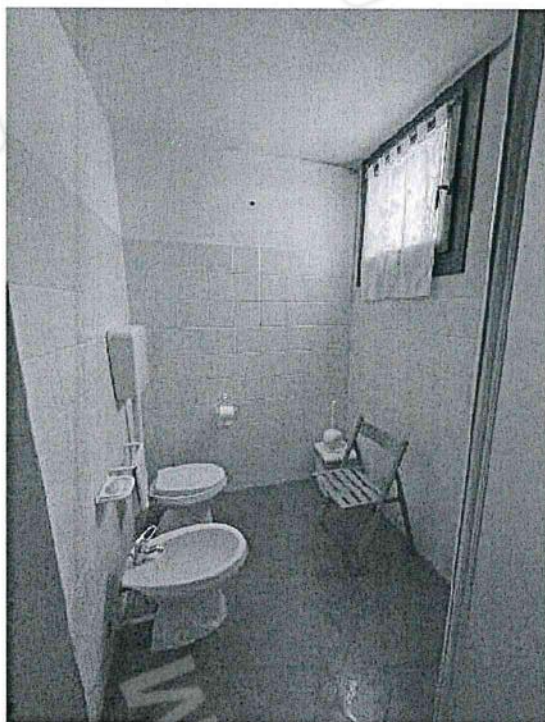
62. Bagno al piano seminterrato.
