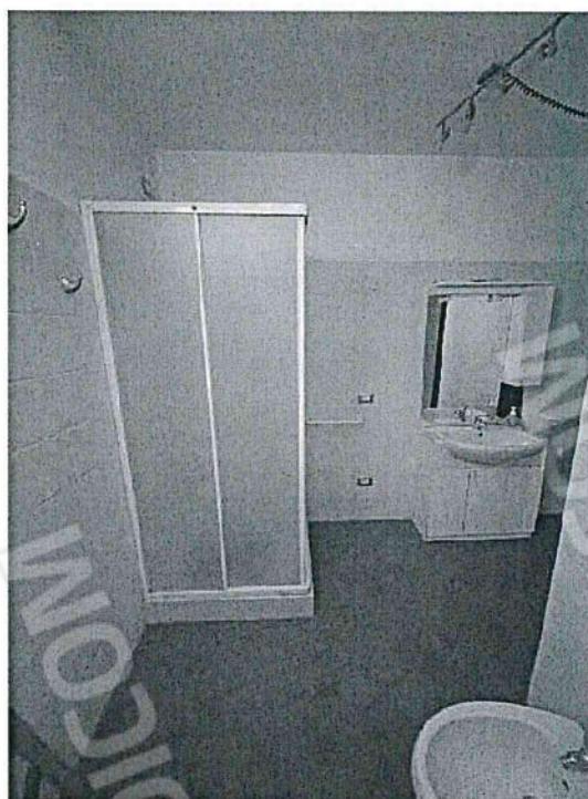
63. Bagno al piano seminterrato.
