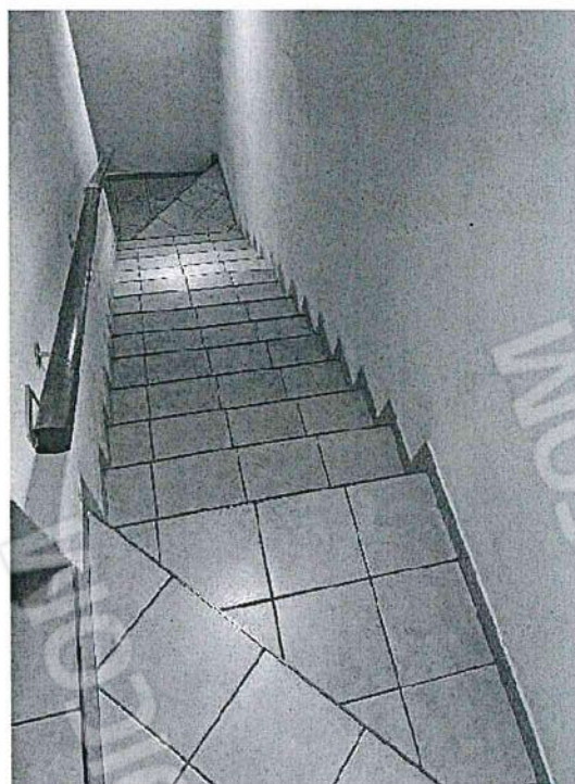
34. Scala di accesso al piano seminterrato.
