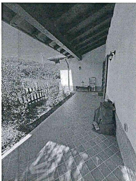
16. Perimetro attorno al fabbricato, lato sud-ovest.
