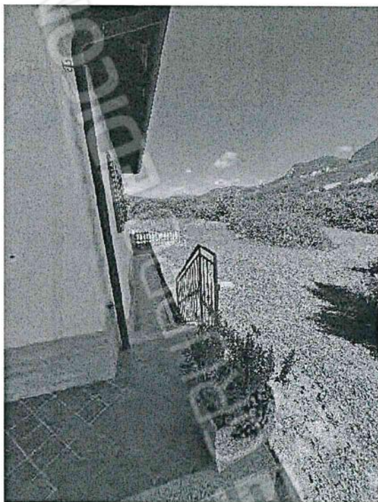
18. Perimetro attorno al fabbricato, lato est.
