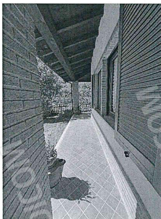
17. Perimetro attorno al fabbricato, lato sud-est.
