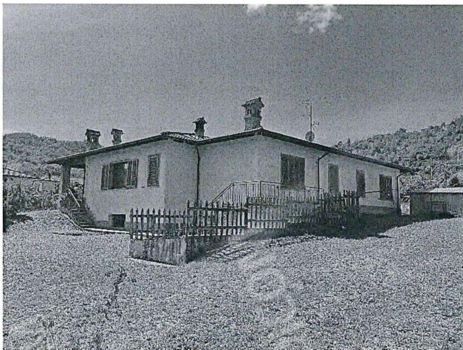
8. Fabbricato residenziale, lato nord.
