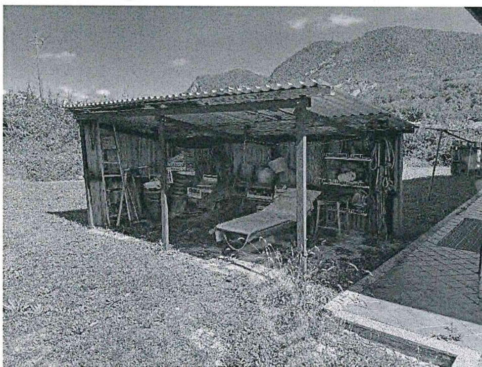
20. Tettoia per ricovero attrezzi da giardino.
