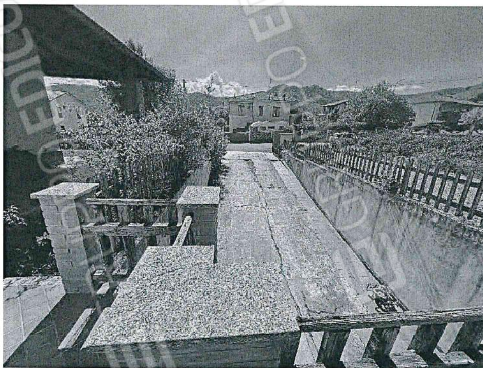
13. Rampa di accesso al box.
