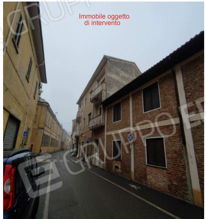
VISTE PRIMA/DOPO FABBRICATO
