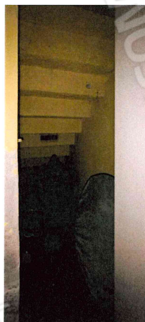
Dettaglio vano sottoscala
