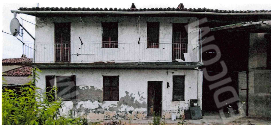
Vista balcone (non accessibile)
