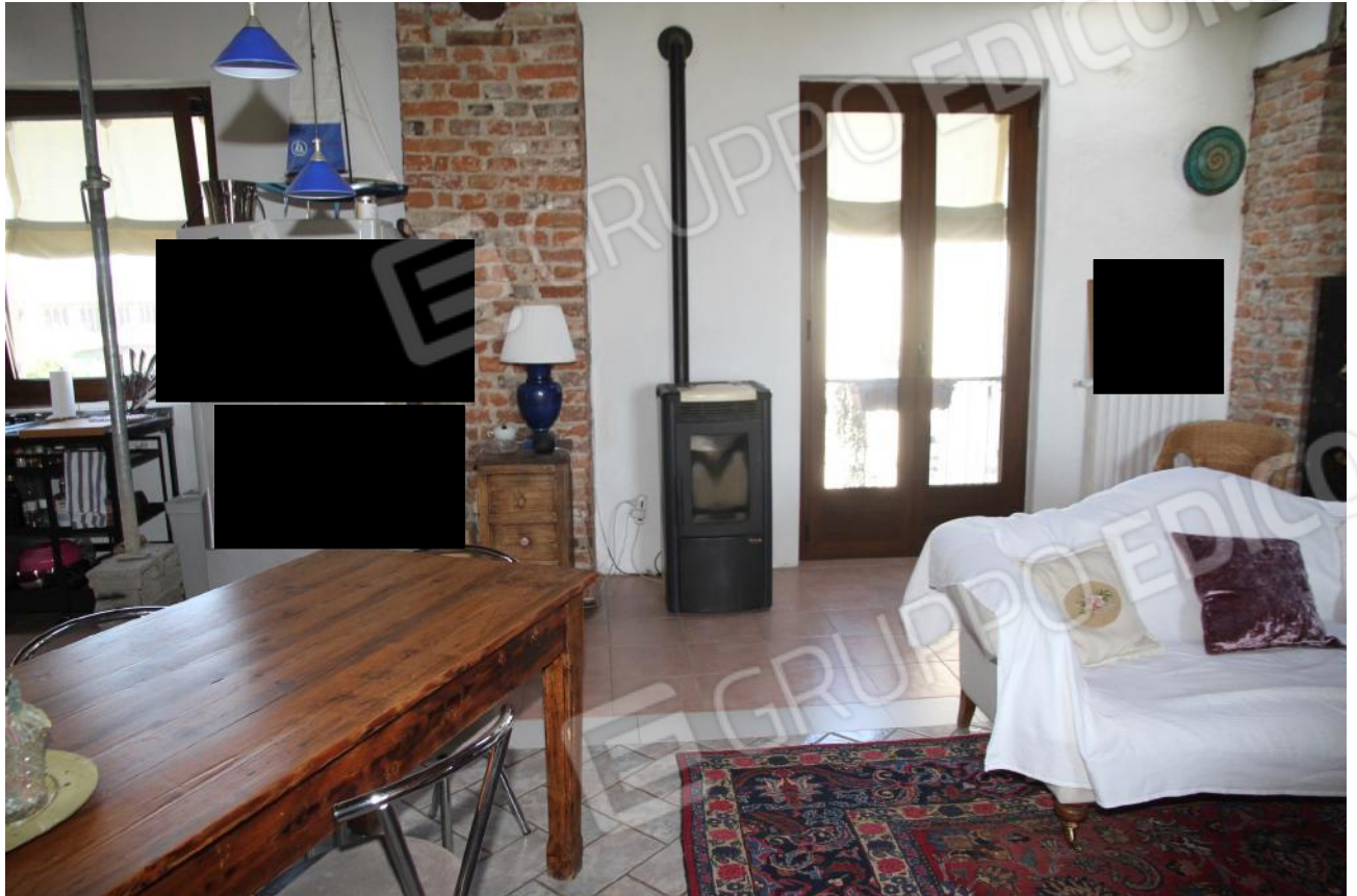
Foto n° 9 - Piano primo open space - caldaia a pellet
