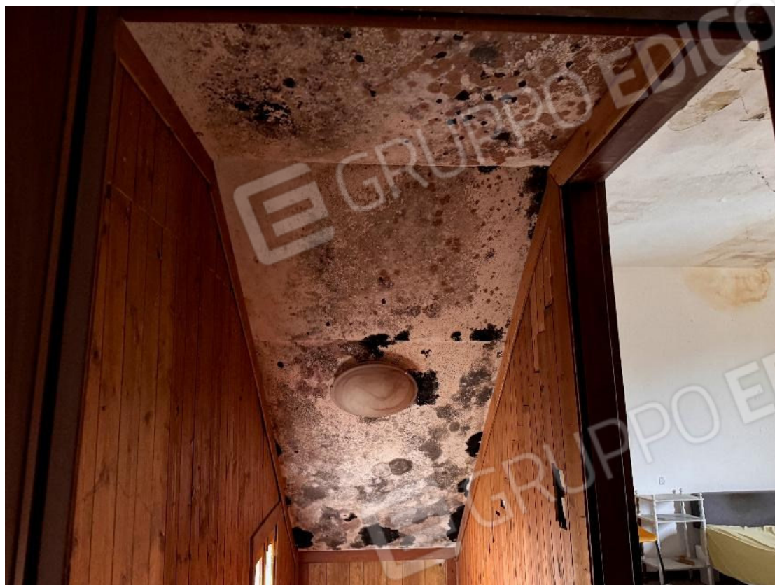
Soffitto sopra scala – presenza gravi infiltrazioni ed efflorescenze
