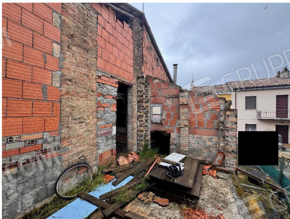
Zona primo piano completamente distrutta : non sono più presenti muri perimetrali e copertura
