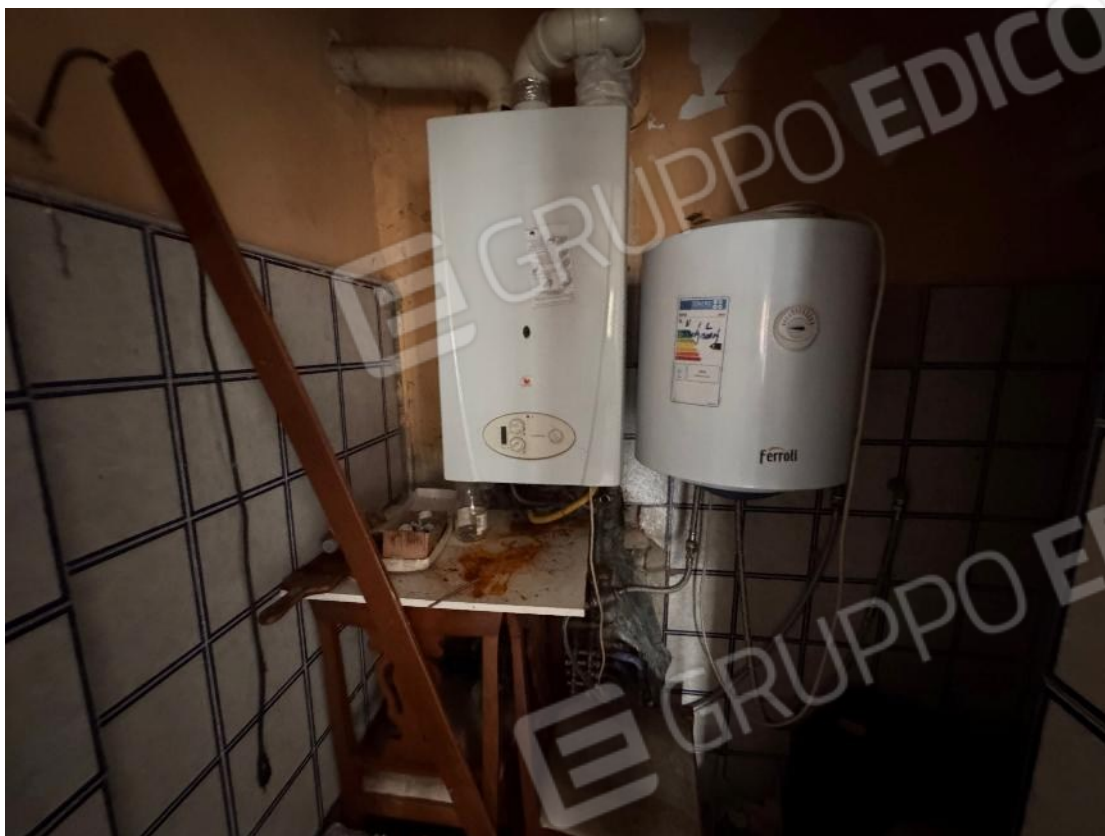
Particolare Caldaia in disuso e produttore ACS elettrico nel sottoscala
