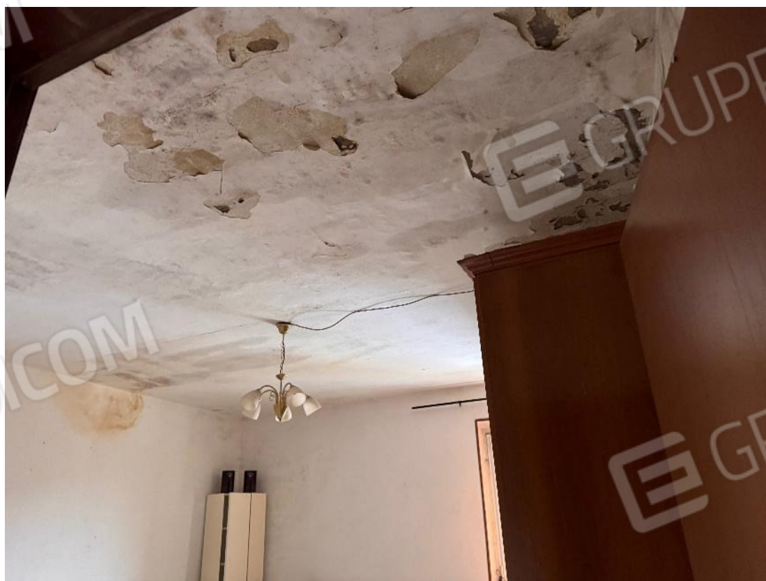
Camera da Letto n.2 – particolare gravi infiltrazioni ed efflorescenze
