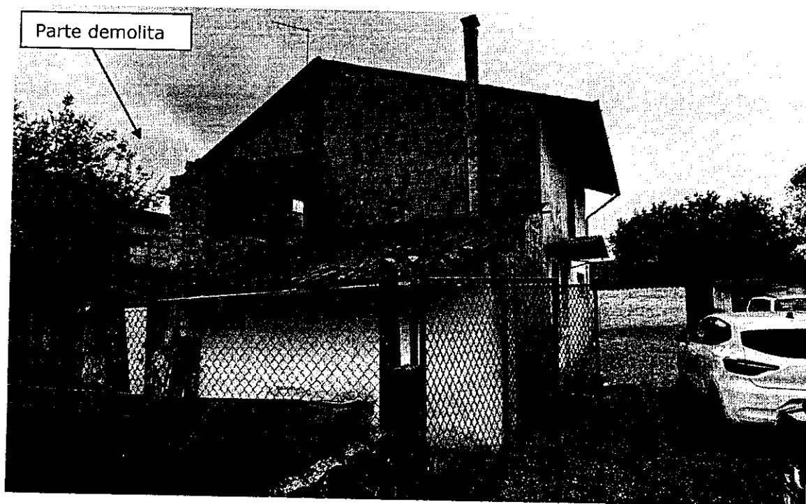
Stato accertato – si noti la assenza parte demolita e tamponatura della parte che era prevista porticato
