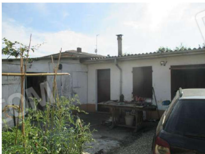
lato est – ripostiglio
