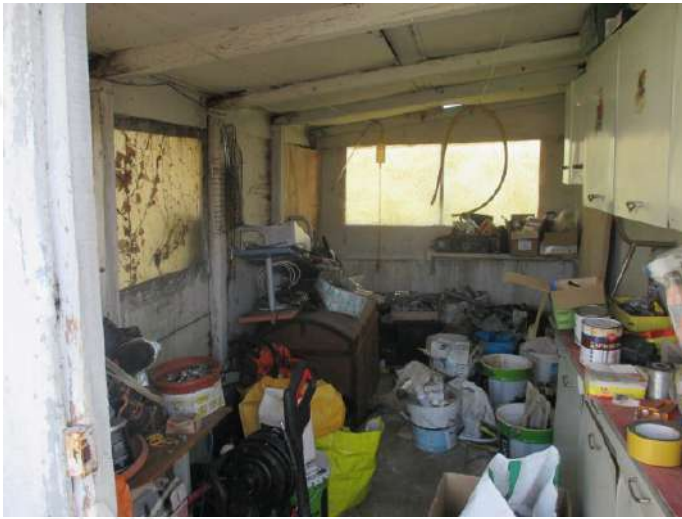
locale di sgombero 4
