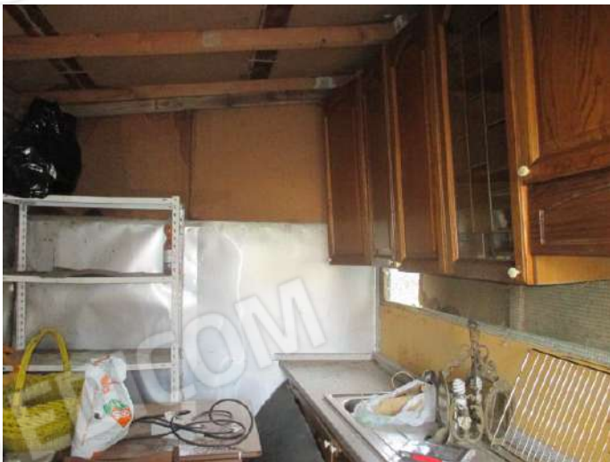
locale di sgombero 2
