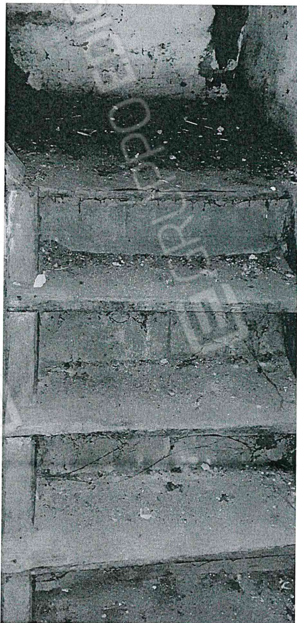
PARTICOLARE SCALA IN LEGNO DA PIANO TERRA AL PIANO PRIMO (NON AGIBILE)
