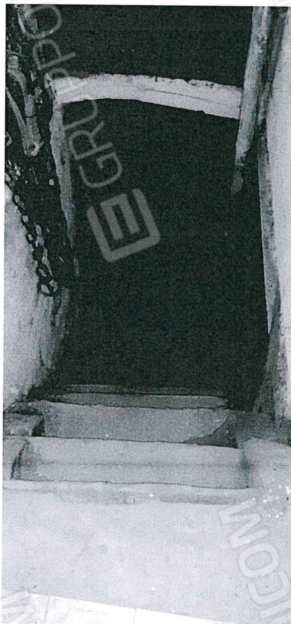
PARTICOLARE SCALA IN LEGNO DA PIANO TERRA AL PIANO PRIMO (NON AGIBILE)
