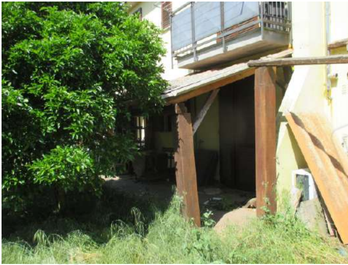
vista palazzina lato giardino
