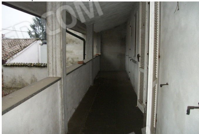
f.7 vista del balcone al piano primo
