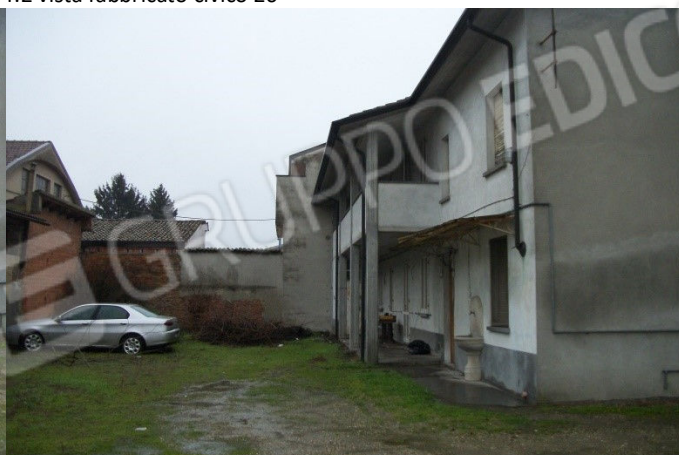
f.4 vista portico con balcone superiore
