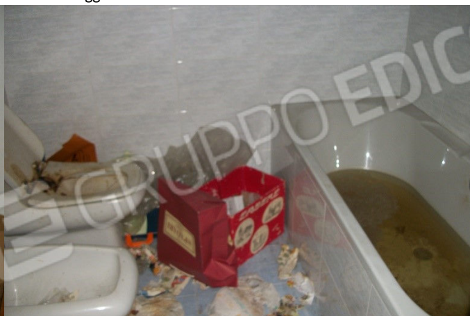
f.20 vista bagno al piano primo
