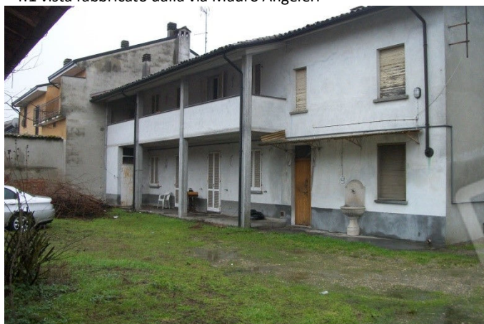
f.3 vista fabbricato dalla corte interna
