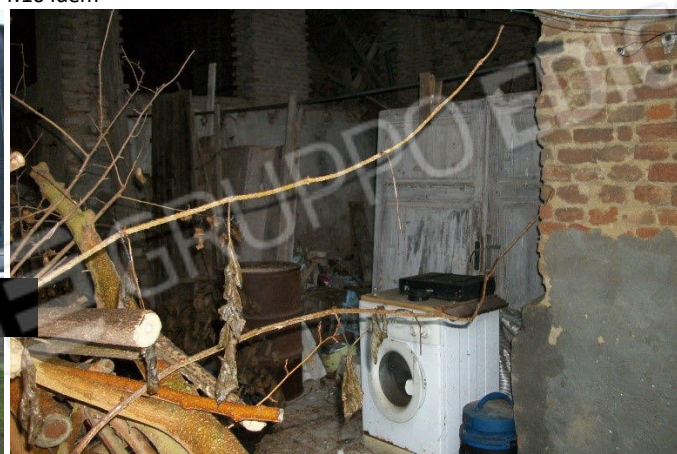
f.12 vista interno fabbricato rurale
