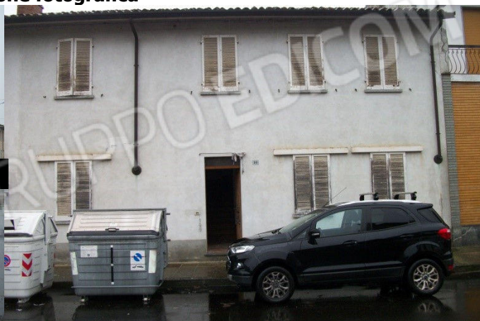
f.2 vista fabbricato civico 20
