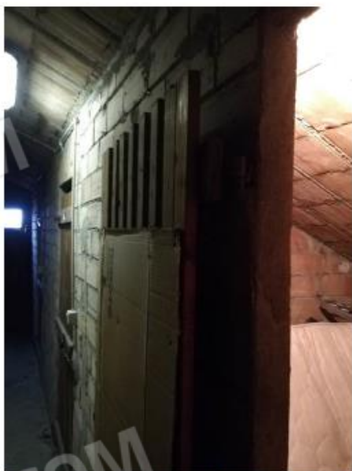
foto 19 – vista esterna da parti comuni della cantina.
