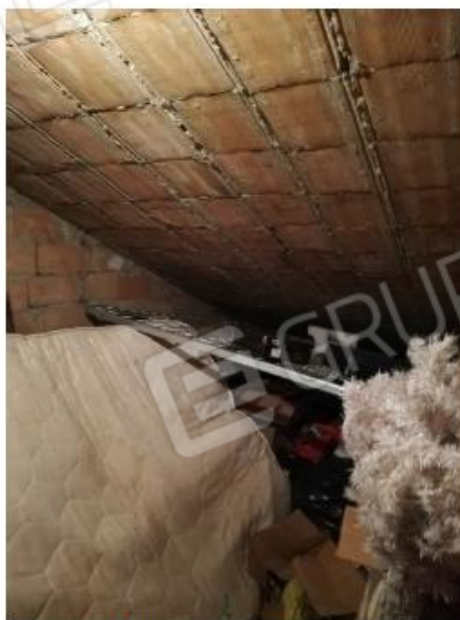
foto 20 – vista interna, cantina.
