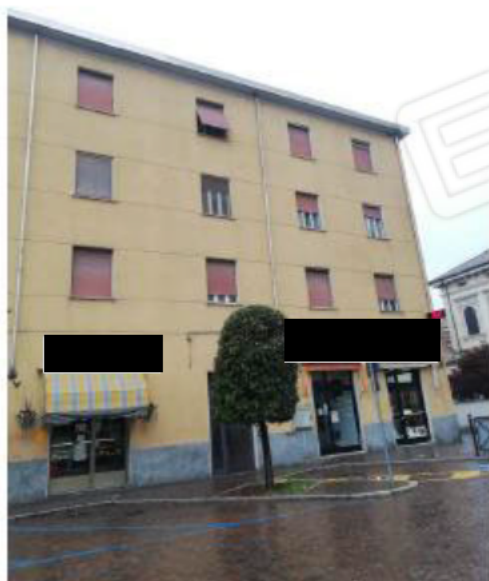
foto 1 – vista esterna dell'immobile.
