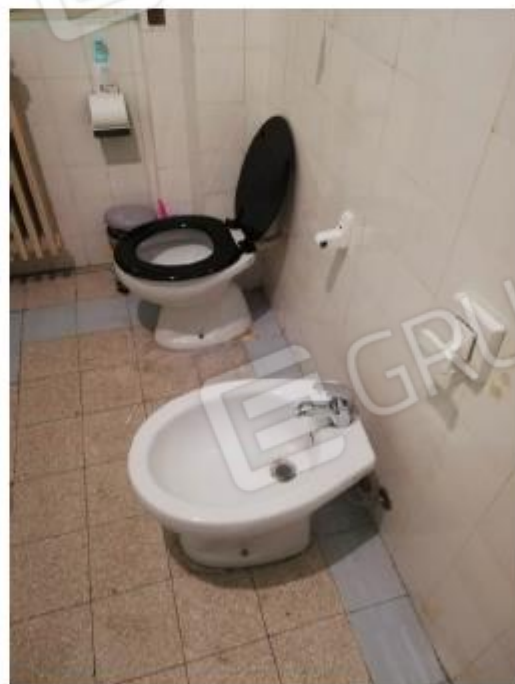
foto 16 – vista interna, servizio igienico.
