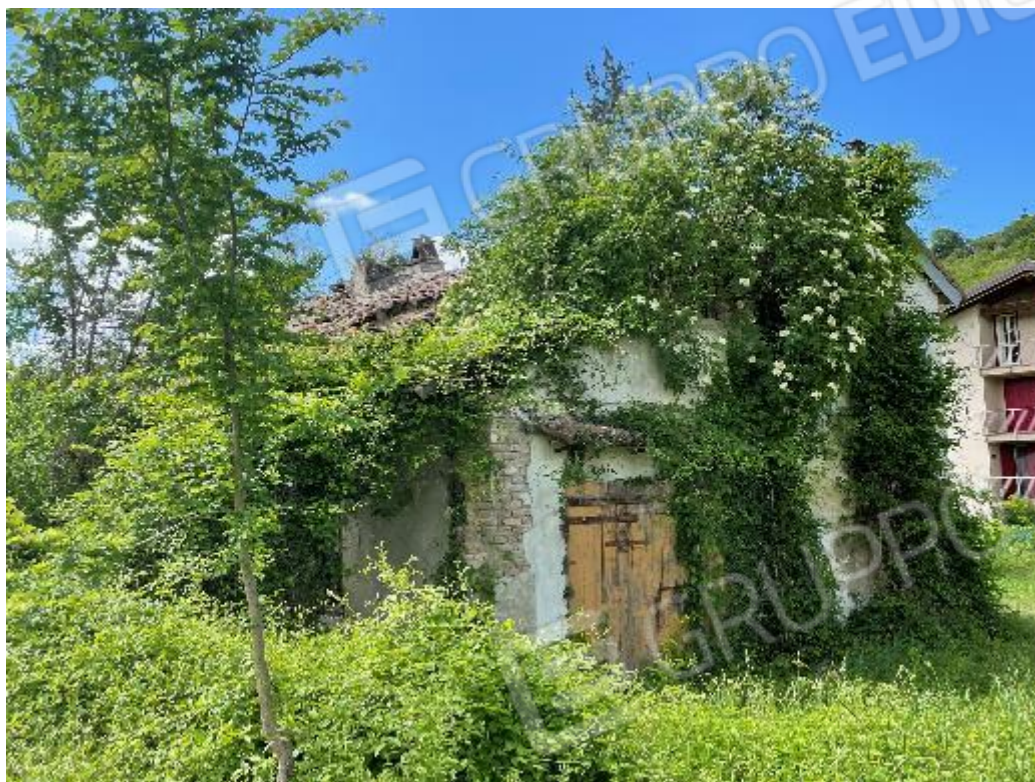
Immobile alla Particella 577 – Subalterno 3 – Prospetto Nord/Ovest
