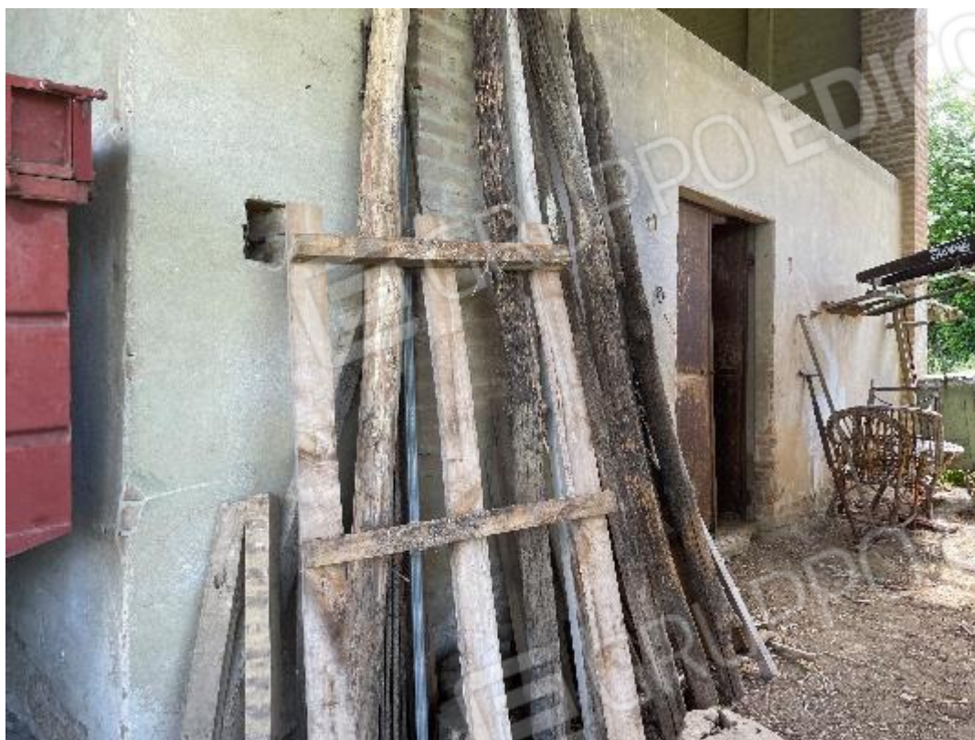
Immobile alla Particella 372 - Portico
