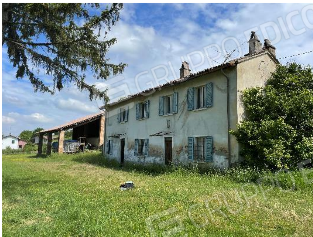
Immobile alla Particella 577 – Subalterno 2 e area di pertinenza – Prospetto Sud/Ovest
