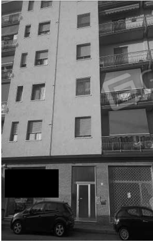
Prospetto su via Lomellina
