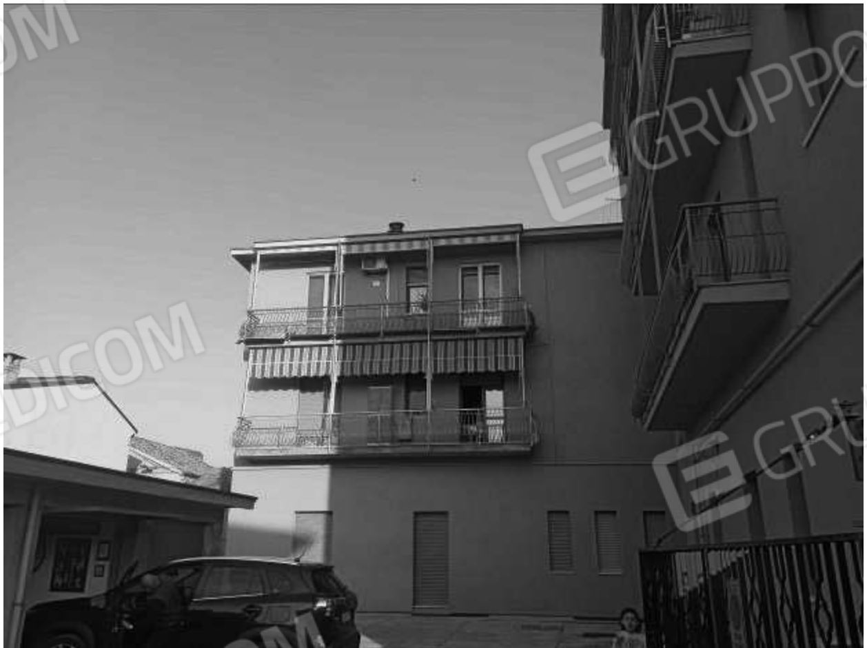
Prospetto su cortile interno
