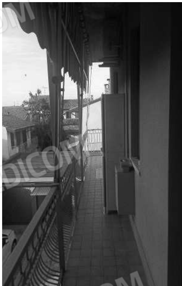
Balcone lato Ovest su cucina e camera 1
