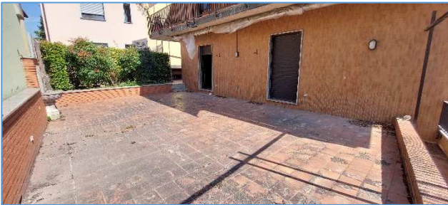
Terrazzo sopra autorimessa
