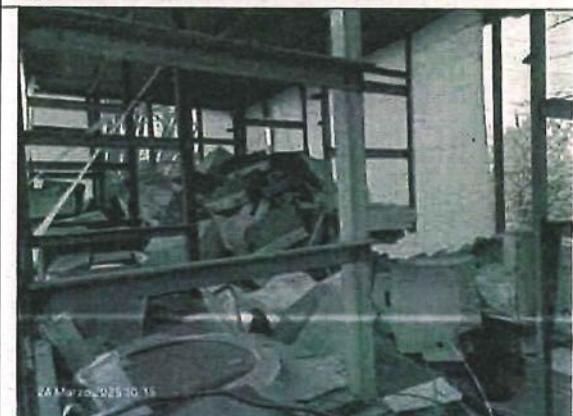
Fig. 45 Interno del box
