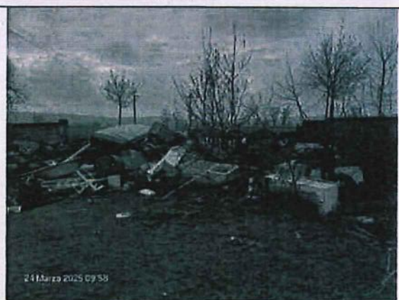
Fig. 4 Vista generale sottocumulo 1
