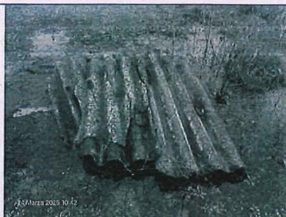
Fig. 48 Cumulo lastre in fibrocemento
