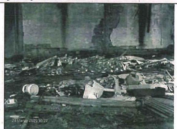
Fig. 66 Cumulo di terra e inerti
