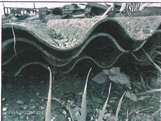
Fig. 22 Dettaglio lastre in fibrocemento
