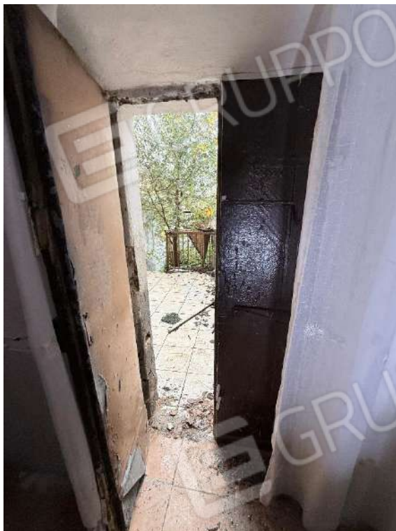
Fabbricato 1 - Abitazione - Piano Terra - passaggio da Cucina ad area pertinenziale esterna
