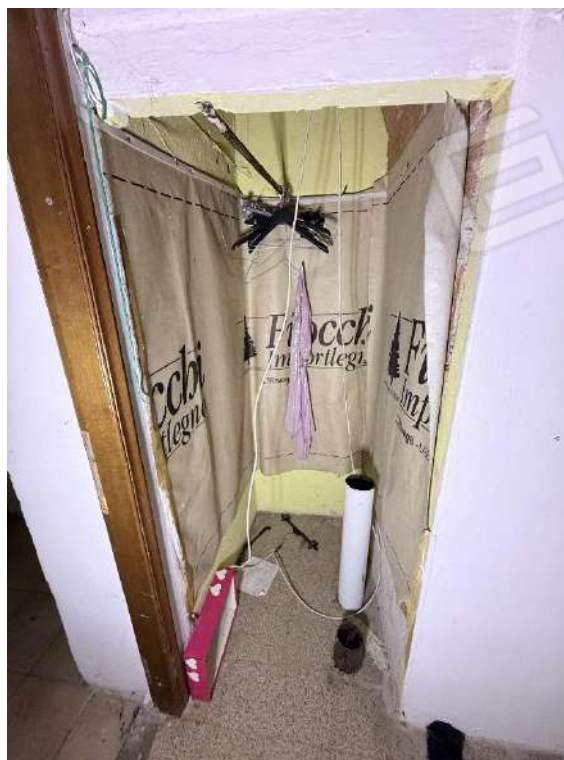
Fabbricato 1 - Abitazione - Piano Primo - Ripostiglio (sottoscala)
