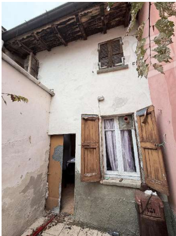
Fabbricato 1 - Abitazione - Vista da terrazzo
