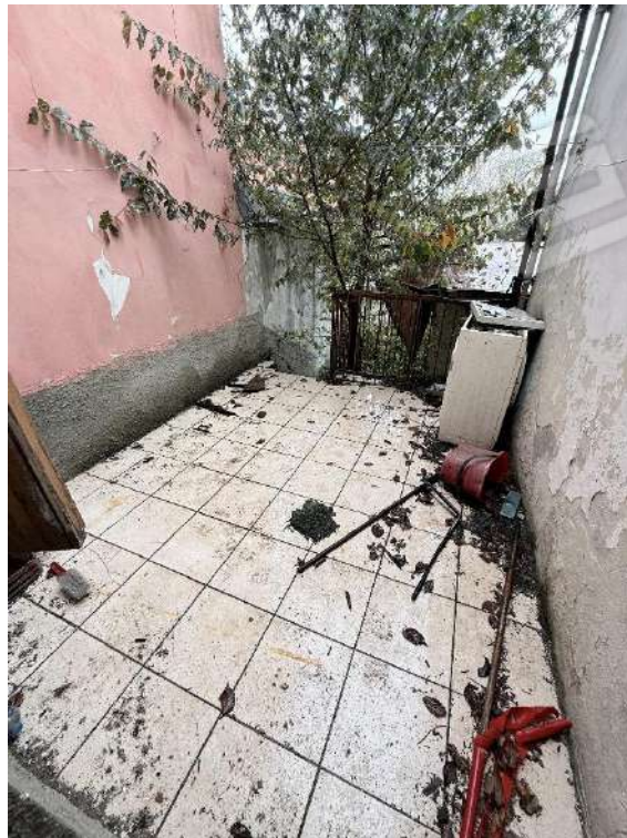
Fabbricato 1 - Abitazione - Piano Terra - Terrazzo (foto 2)
