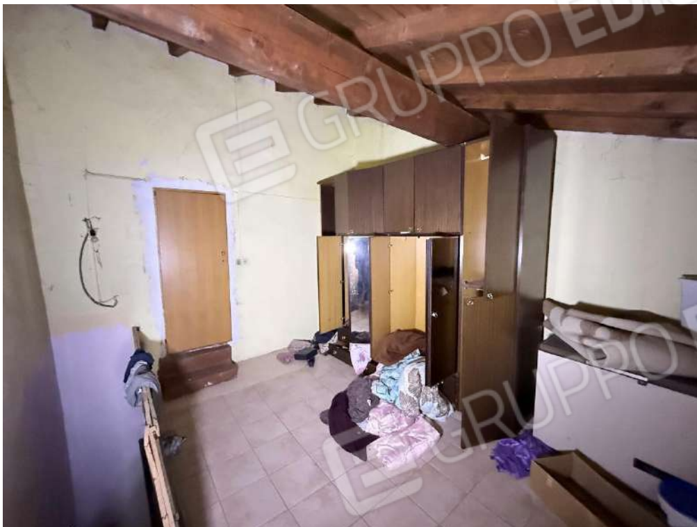
Fabbricato 1 - Abitazione - Piano Primo - Locale 1 (foto 1)
