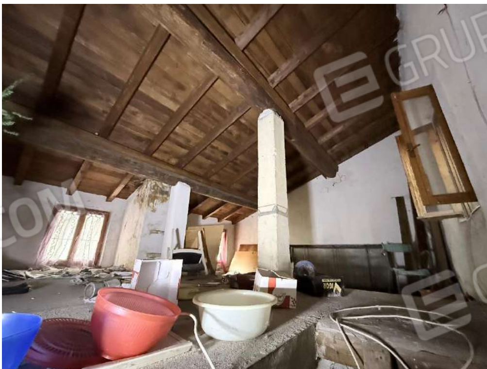
Fabbricato 1 - Abitazione - Piano Secondo - Sottotetto (foto 2)
