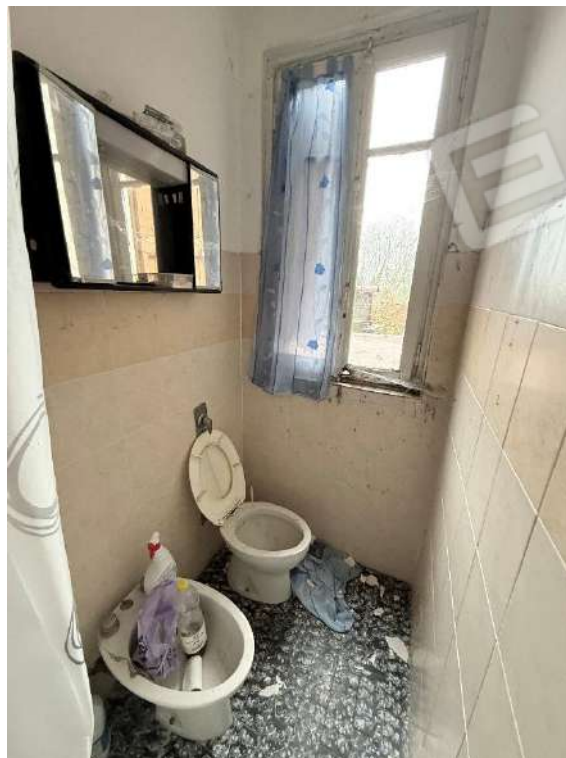
Fabbricato 1 - Abitazione - Piano Terra - Bagno (foto 2)
