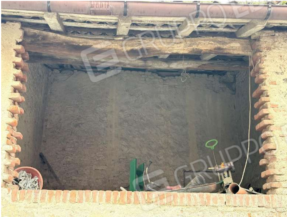
Fabbricato 2 - Rustico - Piano Primo - Legnaia
