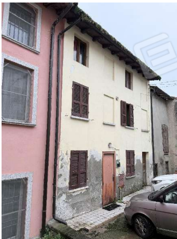
Fabbricato 1 - Abitazione - Vista dalla via Costiolo (foto 1)
