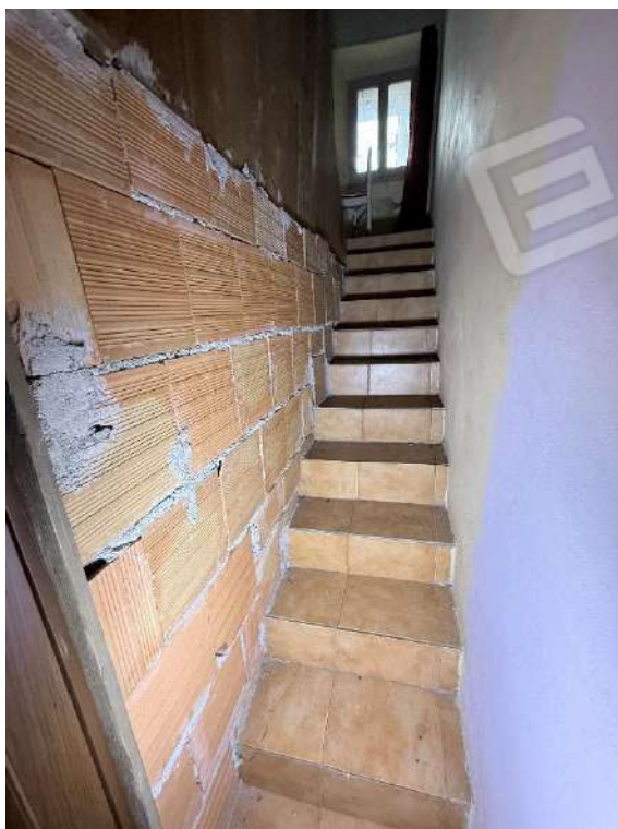
Fabbricato 1 - Abitazione - Piano Terra - Scala (foto 3)
