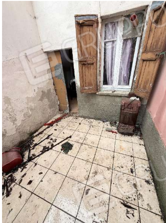
Fabbricato 1 - Abitazione - Piano Terra - Terrazzo (foto 1)
