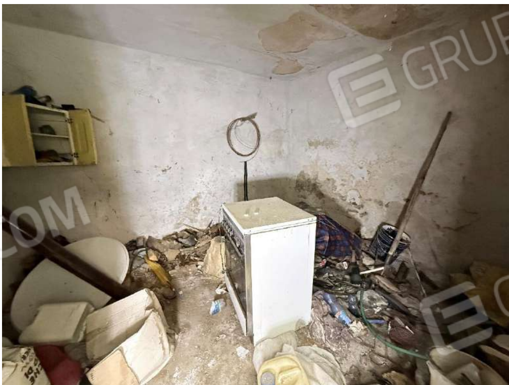
Fabbricato 2 - Rustico - Piano Terra - Locale di sgombero
