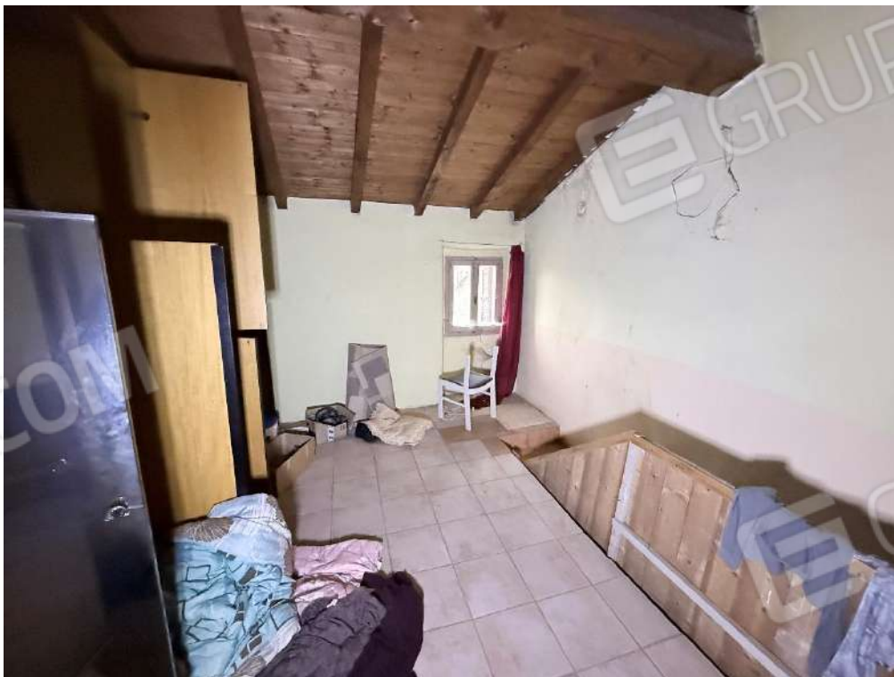
Fabbricato 1 - Abitazione - Piano Primo - Locale 1 (foto 2)
