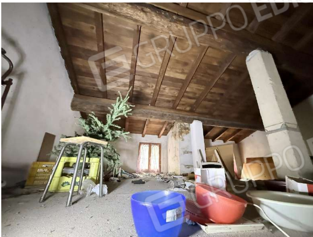
Fabbricato 1 - Abitazione - Piano Secondo - Sottotetto (foto 1)
