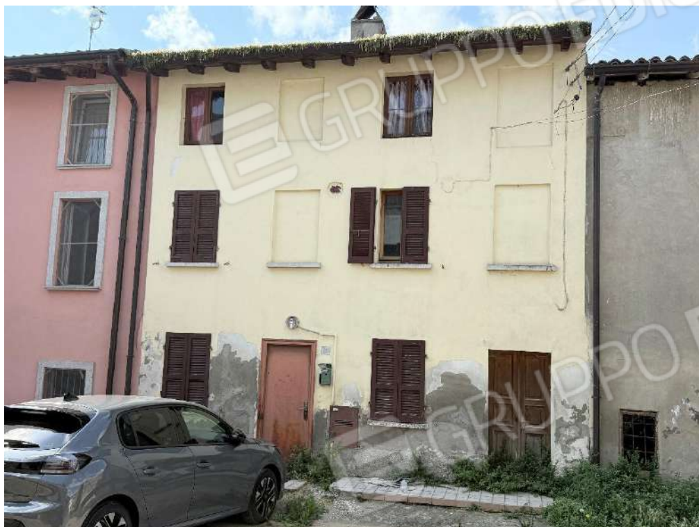
Fabbricato 1 - Abitazione - Vista dalla via Costiolo (foto 2)
