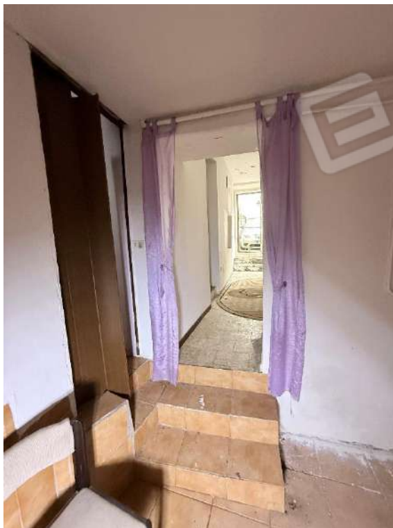
Fabbricato 1 - Abitazione - Piano Terra - Scala (foto 1)
