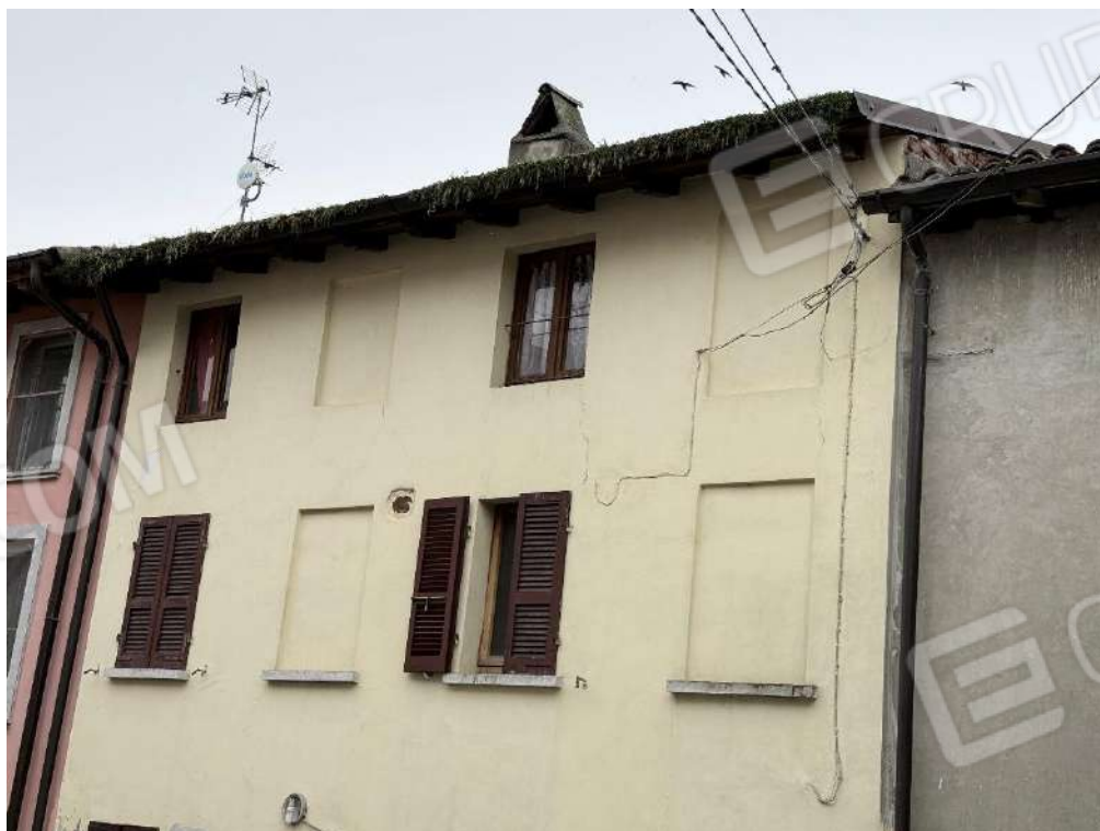
Fabbricato 1 - Abitazione - Vista dalla via Costiolo (foto 3)
