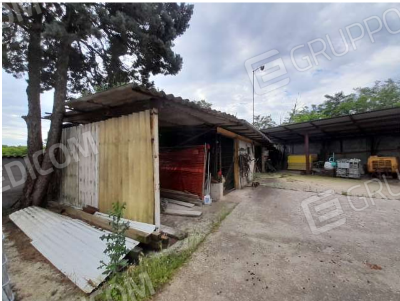
Foto n° 42 – MAGAZZINI E TETTOIA
