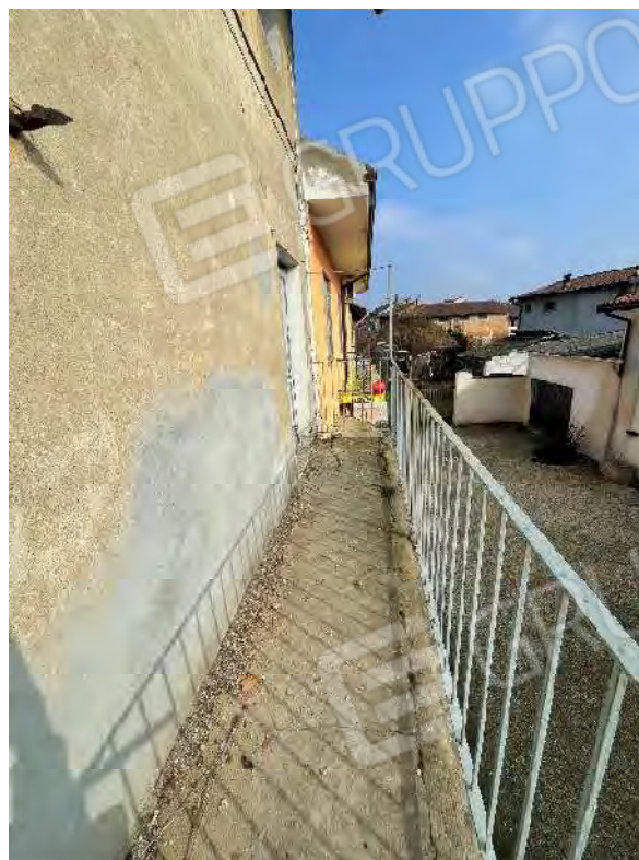
18. Balcone al piano primo.
