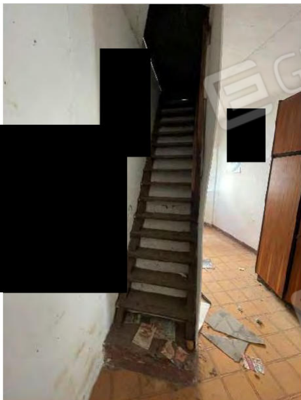
23. Scala di accesso al piano sottotetto.
