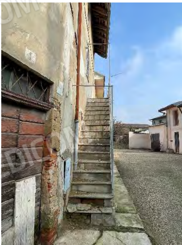
17. Scala di accesso al piano primo.
