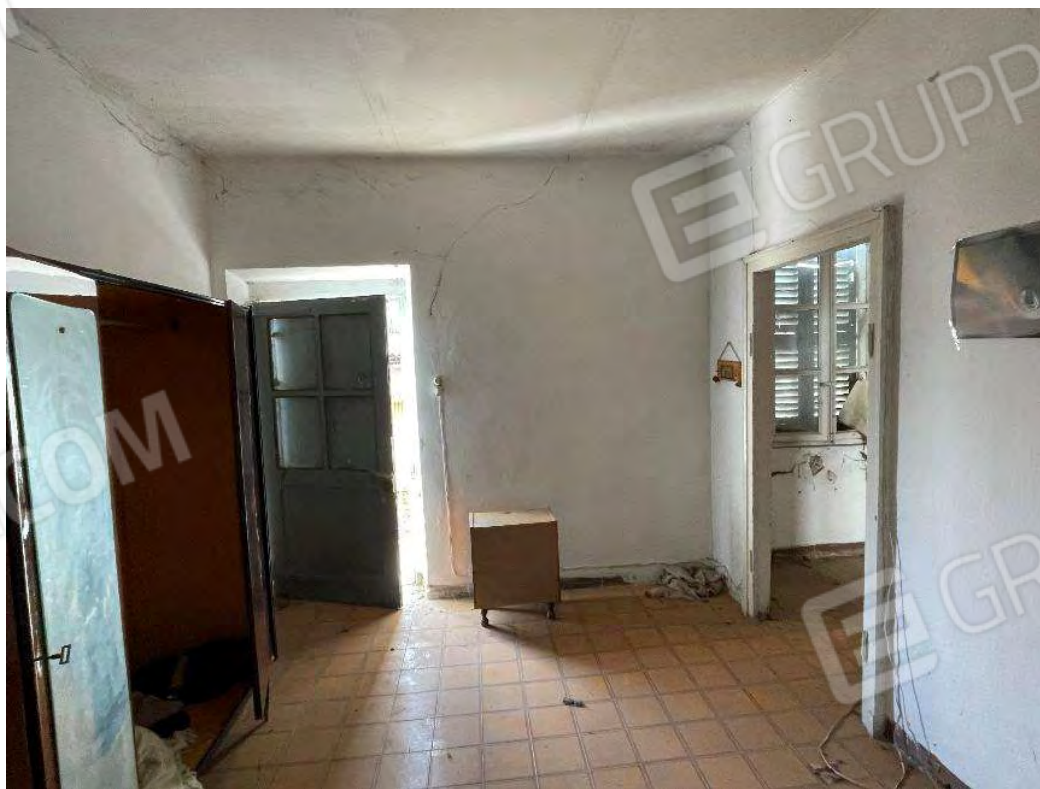
20. Camera 1 al piano primo.
