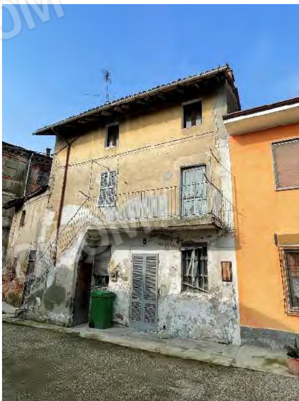
9. Fabbricato residenziale, fronte principale.
