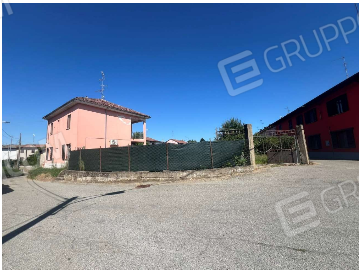
Vicolo Ossario – immobile affaccio su strada
