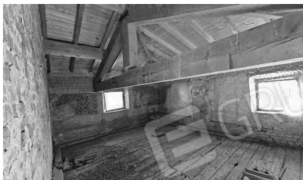
21. Particolare della struttura a capriata
