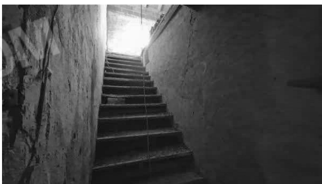
18. Accesso al sottotetto
