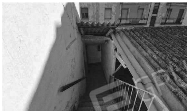
5. Scala di accesso
