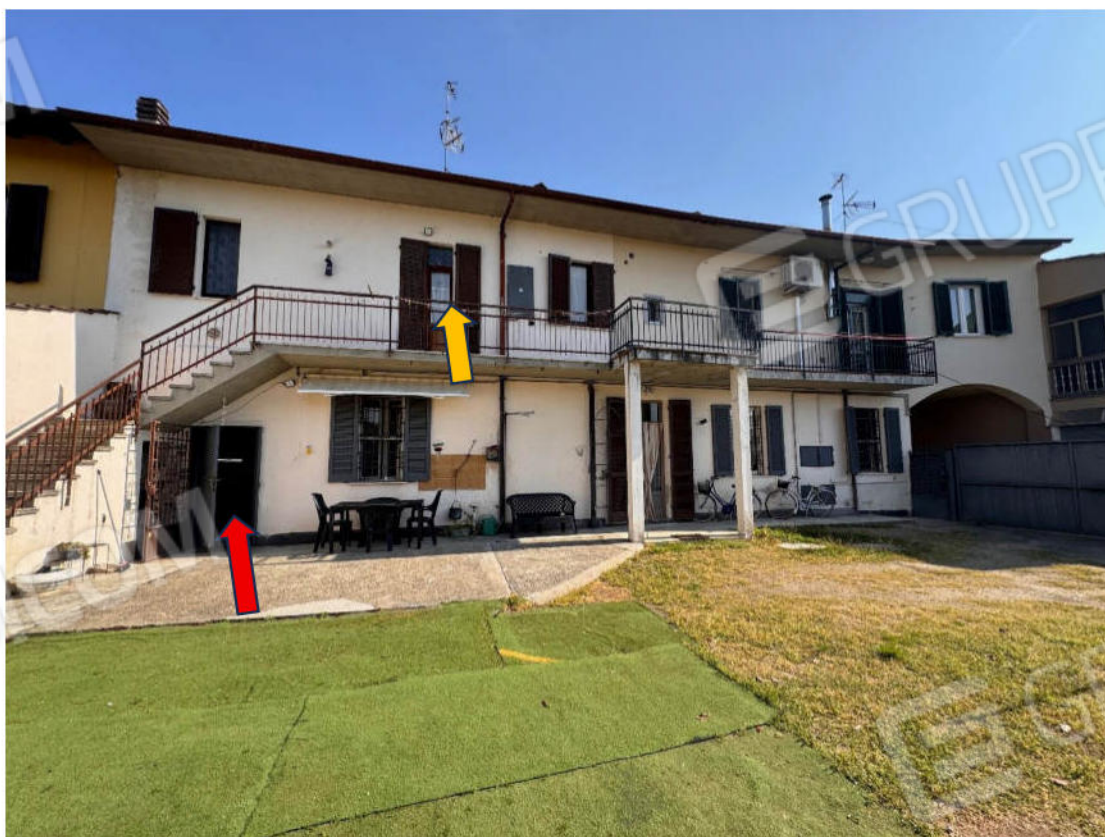
Vista esterno corpo di fabbrica di cui al mappale 542.
