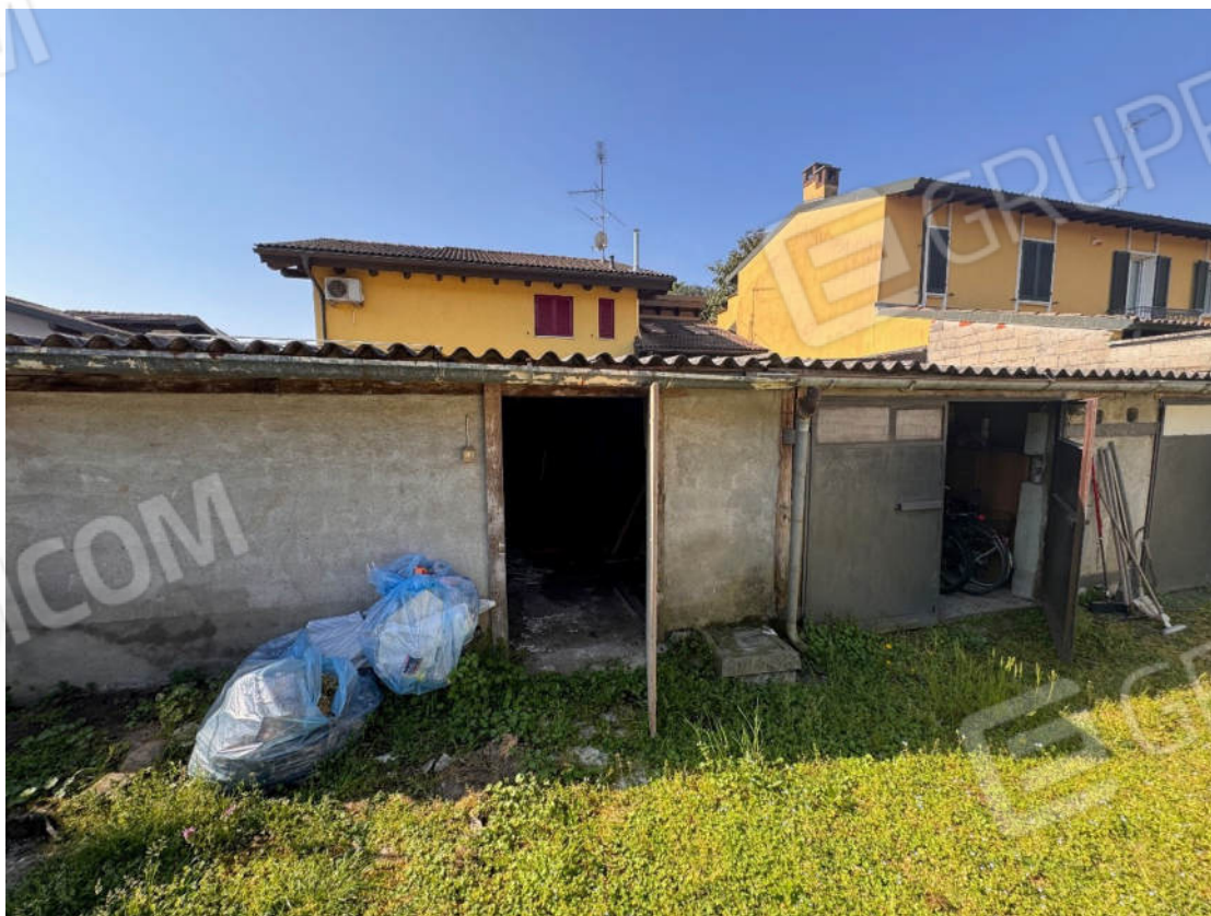
Accesso a Locale Legnaia
