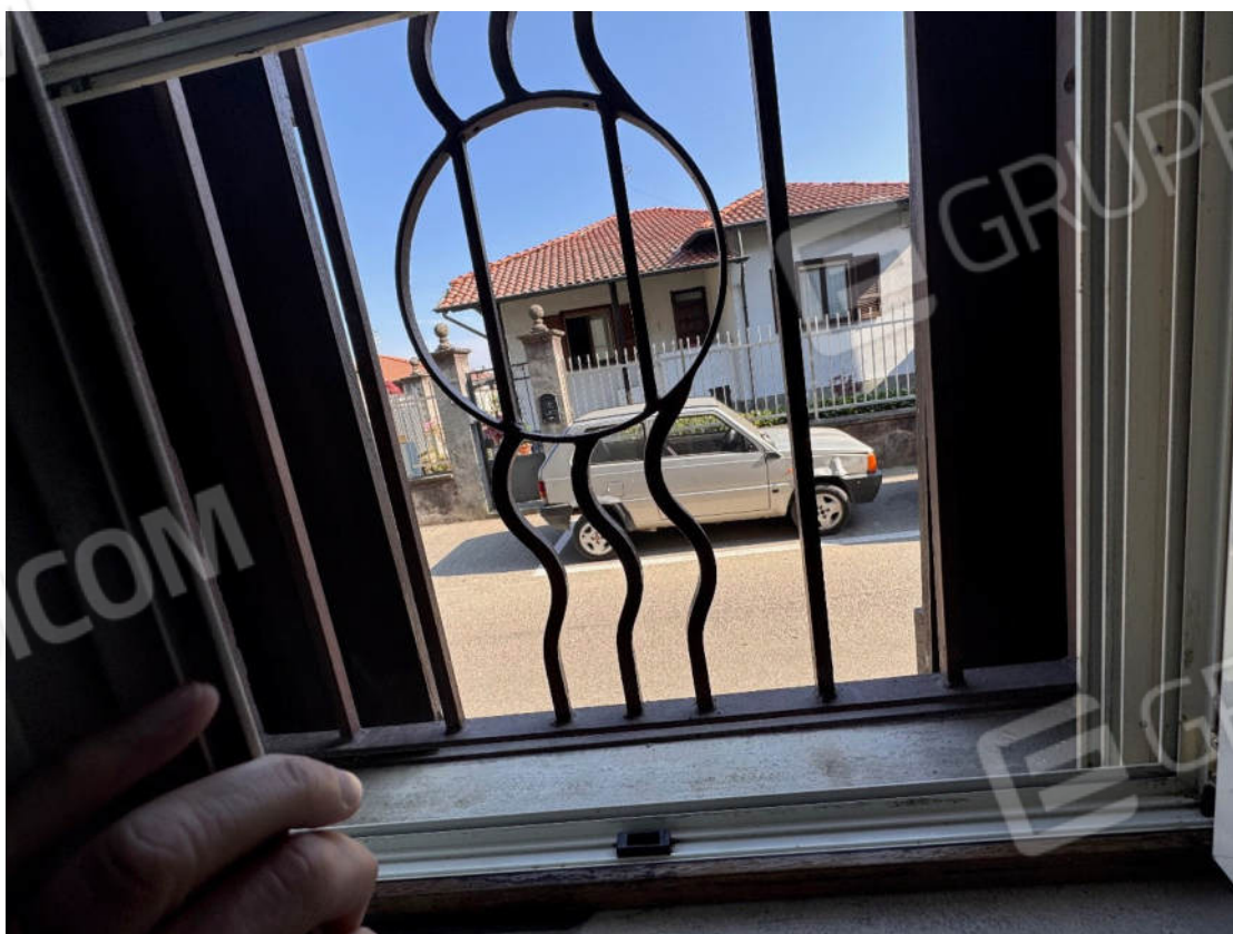
Camera da Letto n.1 – particolare inferriata
