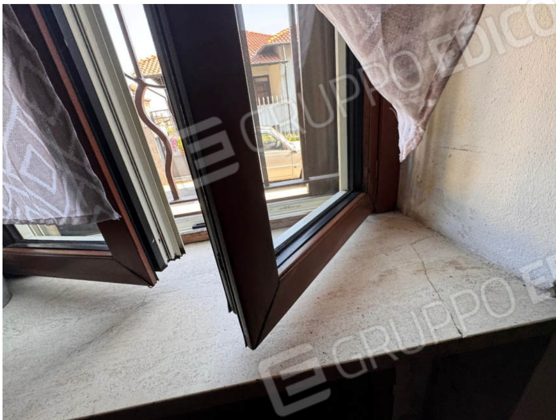
Camera da Letto n.1 – particolare serramento
