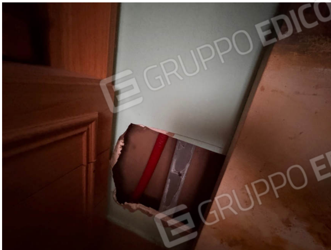
Particolare tubazioni a vista e muro di cartongesso a separazione del locale bagno
