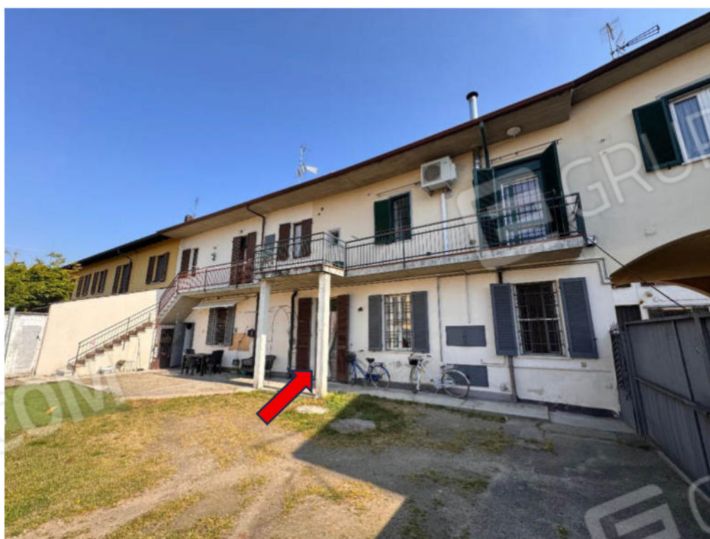
Vista Esterno corpo di fabbrica fg.27 part.512 l'accesso al sub.11 è identificato dalla freccia rossa
