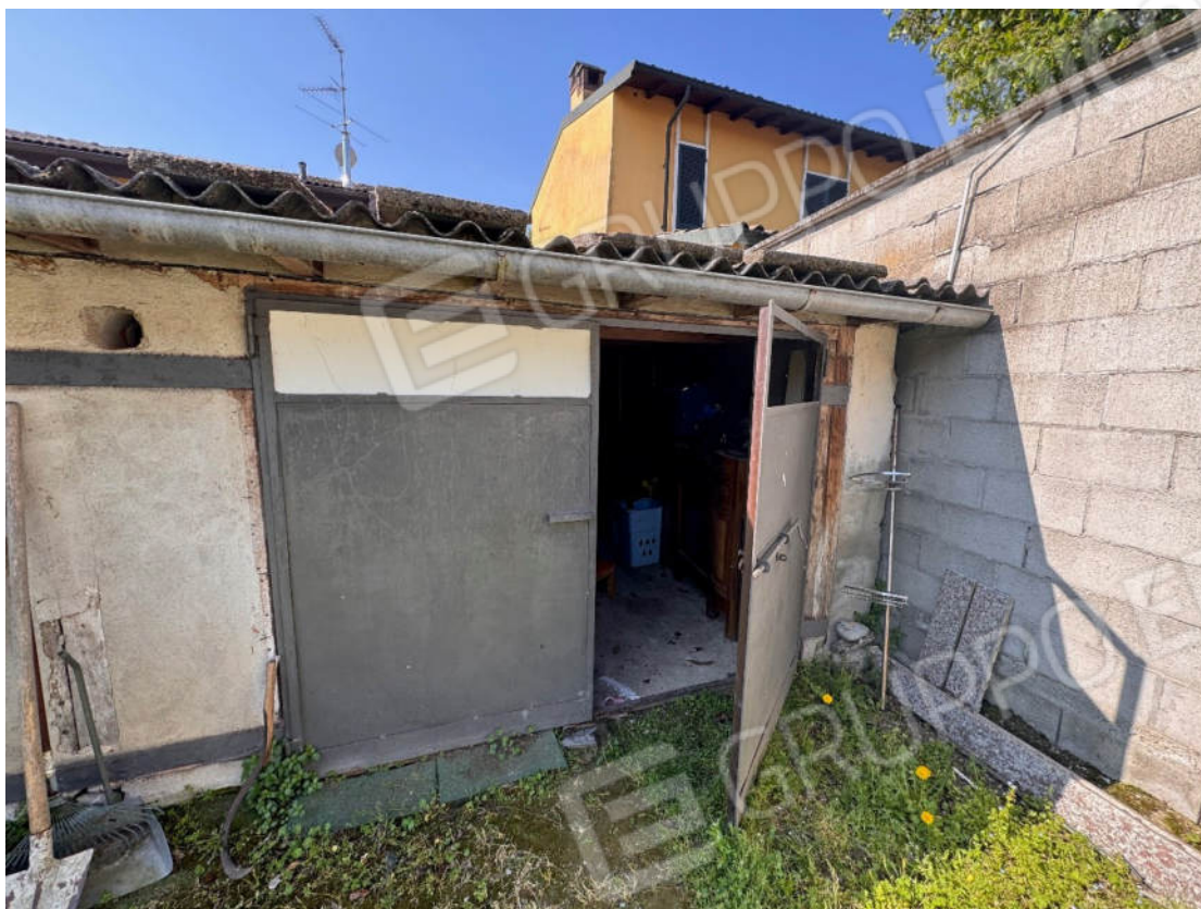
Accesso al Locale Sgombero
