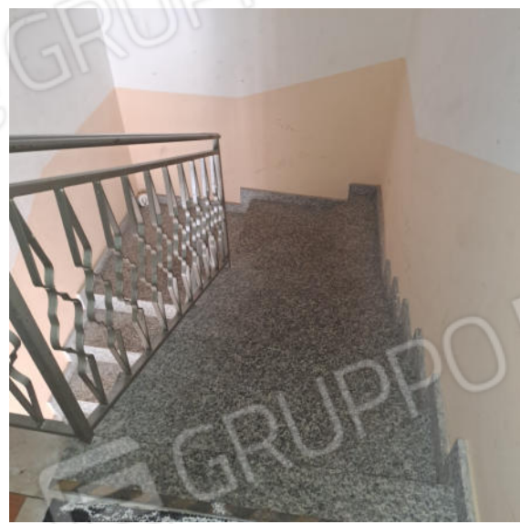
Foto 10 – Vano scala comune dal piano primo
