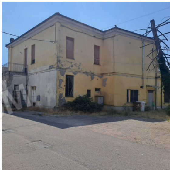
Foto 3-Edificio dalla strada interna I-Lato nord-ovest
