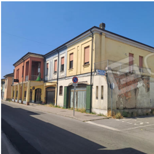
Foto 1-Edificio da Via Umberto I-Lato est-nord
