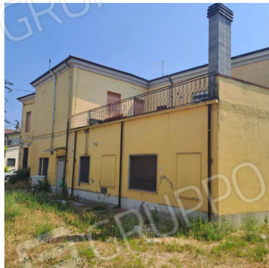
Foto 4 - Edificio dalla corte interna I-Lato ovest-sud
