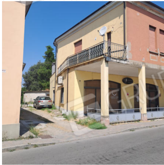
Foto 6 - Edificio dalla corte interna I-Lato sud-est
