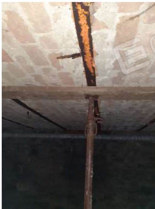
PARTICOLARE soffitto cantina al piano interrato
