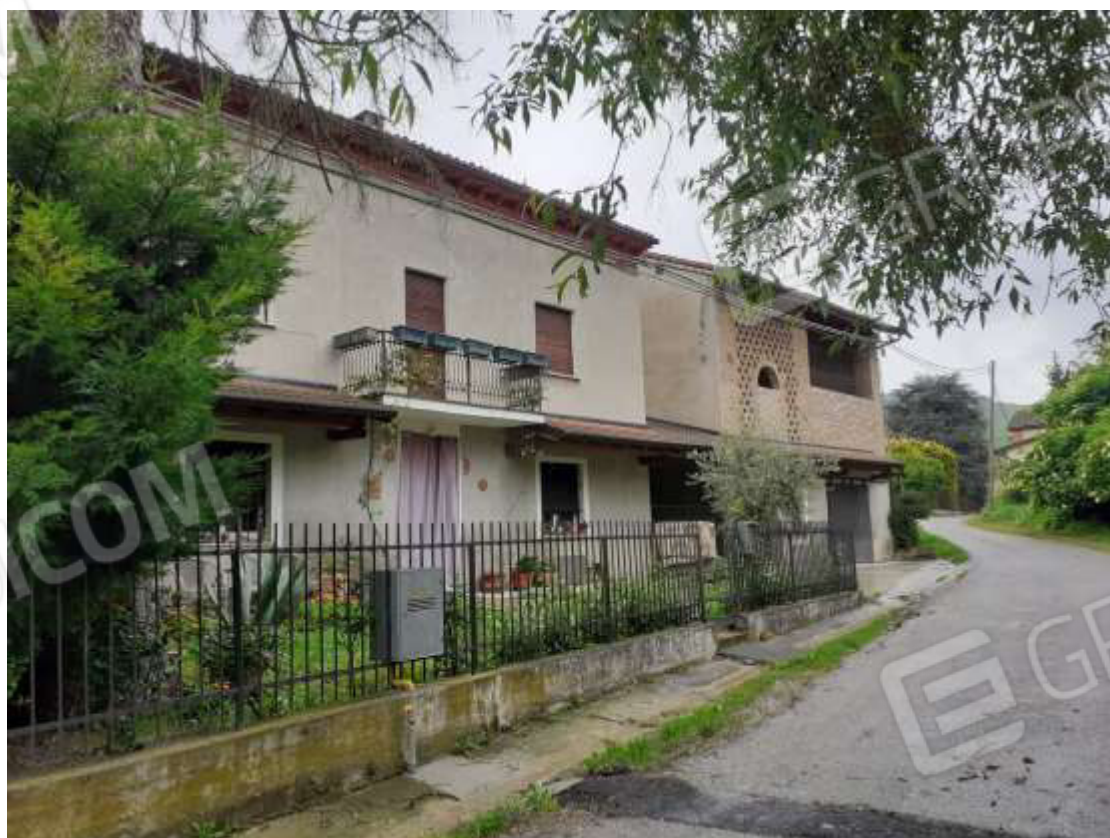
Fronte principale Abitazione (verso S.P. 203)
